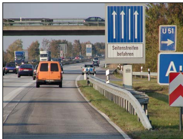
Bild 21: Temporäre Freigabe auf der A 7
