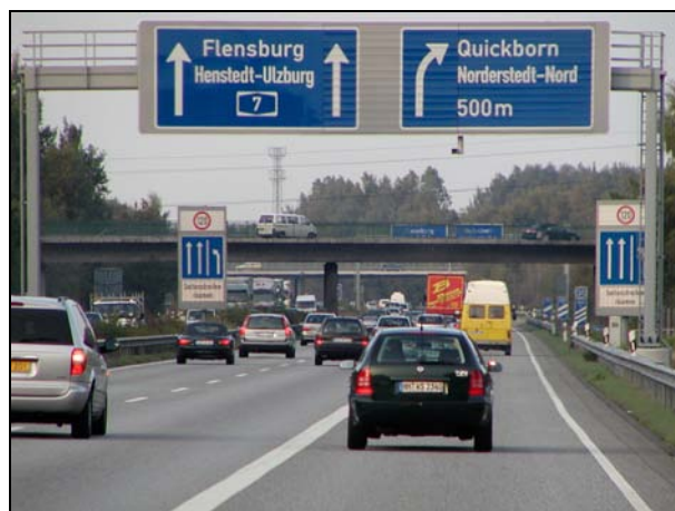
Bild 22: Wechselwegweisung zur Unterstützung der Freigabe auf der A 7
