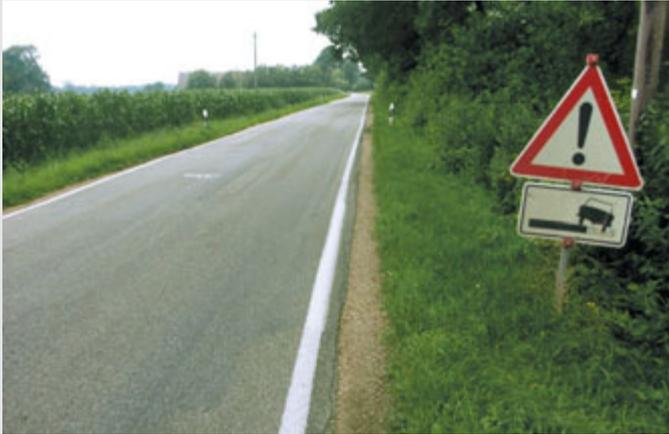
Bild 7: Ausgefahrener Fahrbahnrand
