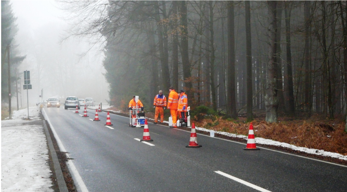
Bild 6: Bei der Salzaufnahme im linken Fahrstreifen (in Streurichtung gesehen)
