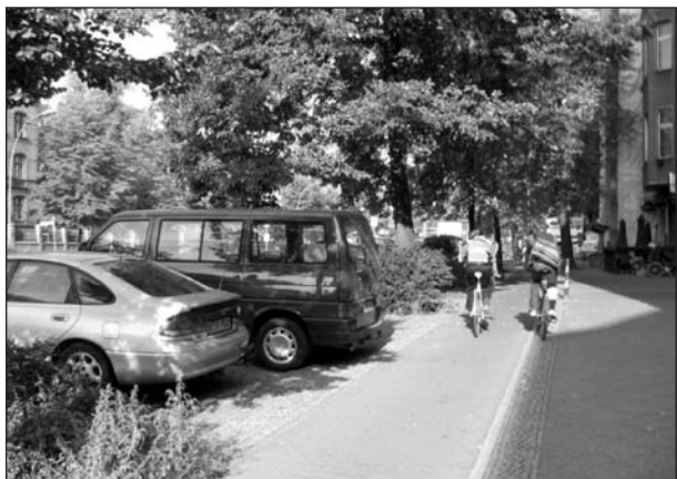
Bild 6-1: Nutzung des Gehweges für den Überholvorgang (Radweg mit Benutzungspflicht, Prenzlauer Allee (Berlin))
