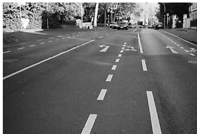
Bild 24: Integrierter Schutzstreifen (Brühl)
