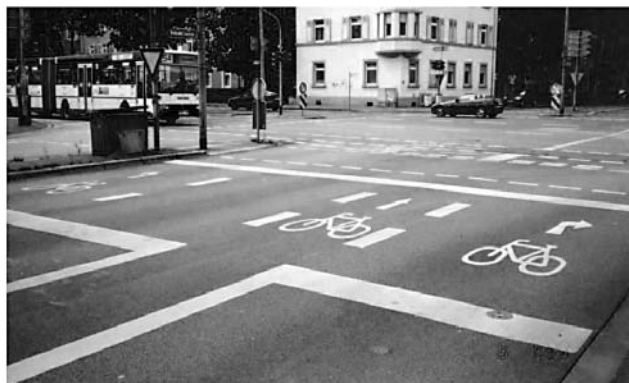
Bild 21: ARAS mit mehr als 4 m Länge (Wiesbaden)
