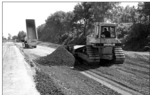
Bild 4: Einbau von Hausmüllverbrennungssasche im Dammkörper
