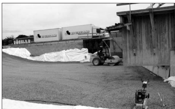
Bild 6: Verdichtung mit statisch betriebener Walze und Rüttelplatte
