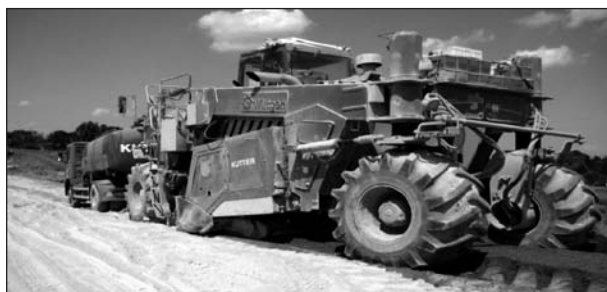
Bild 2: Durchfräsen von Boden und Bindemittel unter Wasserzugabe zu einem homogenen Gemisch
