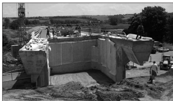
Bild 4: Teilverfülltes Widerlager, Verdichtung mit Plattenverdichtern
