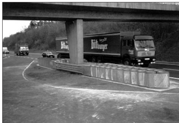
Bild 51: Beispiel eines Anpralldämpfers vor einem Brückenpfeiler (Foto: SPS)
