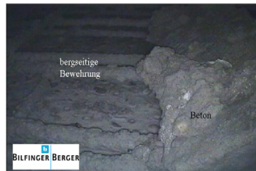
Bild 14: Block 136.2, Videoscope-Aufnahme durch den Firstspaltinjektionsstutzen nahe des Rasterpunktes 732
