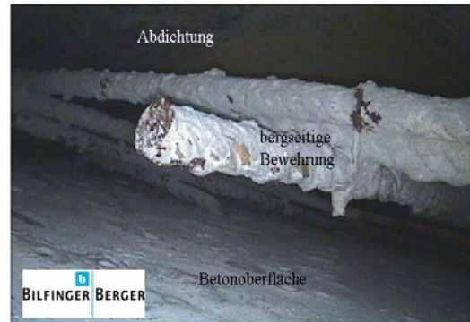
Bild 13: Block 136.2, Videoscope-Aufnahme durch den Firstspaltinjektionsstutzen nahe des Rasterpunktes 732
