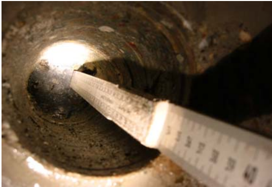
Bild 10: Block 137.2, Bohrloch an der Stahlplatte
