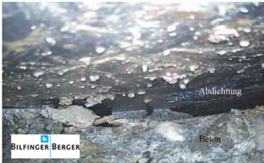
Bild 16: Block 137.2, Videoscope-Aufnahme durch den Firstspaltinjektionsstutzen nahe des Rasterpunktes 330
