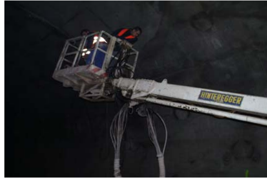
Bild 8: Korb des Hubsteigers, der als Messplattform benutzt wurde
