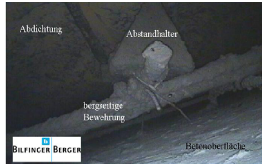
Bild 12: Block 136.2, Videoscope-Aufnahme durch den Firstspaltinjektionsstutzen nahe des Rasterpunktes 732
