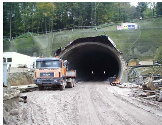
Bild 2: Westportal, Tunnelröhre Nord während der Bauphase
