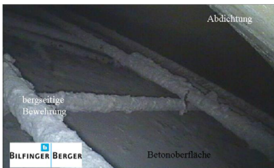
Bild 11: Block 136.2, Videoscope-Aufnahme durch den Firstspaltinjektionsstutzen nahe des Rasterpunktes 732
