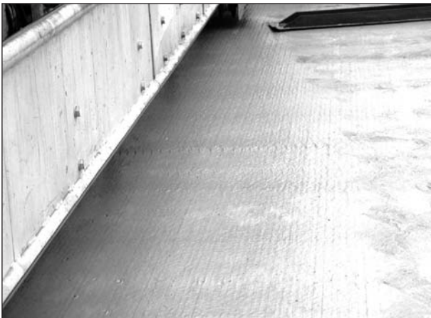
Bild 6.11: Struktur nach Querglätter und Einfluss des Längsglätters
