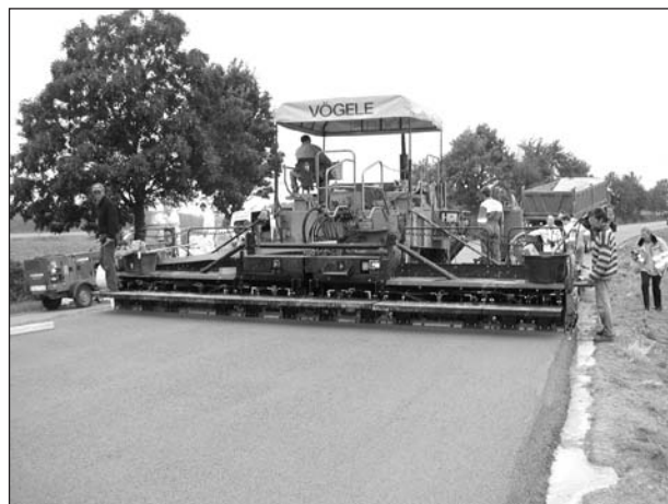
Bild 6.9: Einbau Dränbeton B56
