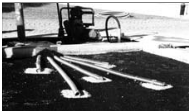
Bild 11: Einbau der Kabelkanäle auf der Tragschicht
