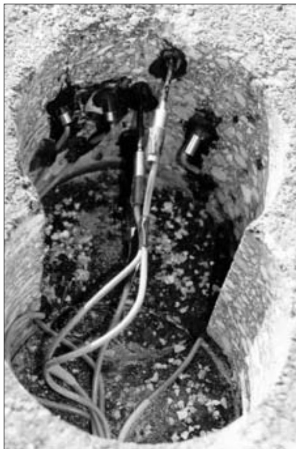
Bild 14: Einbau der Thermoelemente von Pt-100 im Bohrloch
