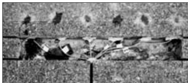
Bild 56: Einbau von 6 Thermolementen in die Fahrbahn (ohne Vergussmasse)
