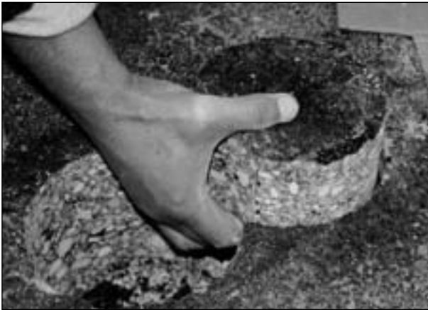
Bild 16: Einsetzen eines Bohrkernes
