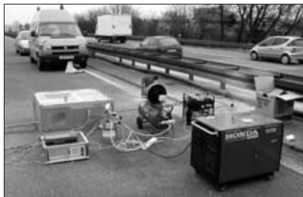
Bild 16: Einsatz der Prüfvorrichtung auf der Fahrbahn
