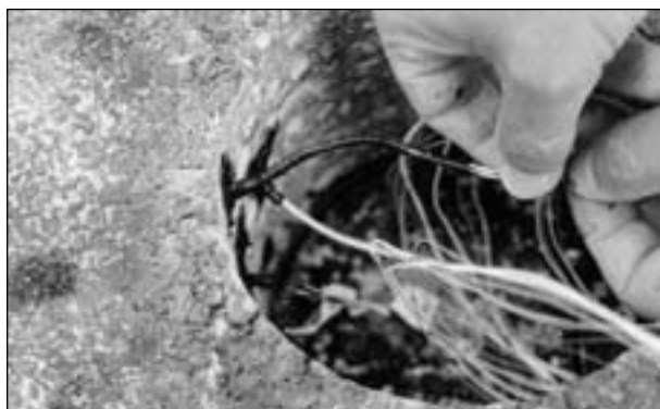
Bild 13: Einschleiben eines Pt-100 für die Fahrbahnoberflächentemperatur mit Bitumenmörtel in eine Bohrung
