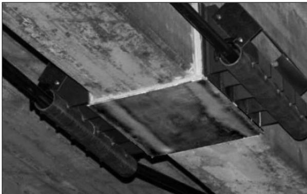
**Bild 90:** Umlenkstelle bei der Brücke ü. Rostocker Seehafen im Zuge der BAB A 19 [AlBe11]
