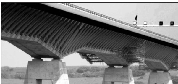
Bild 40: Boulonnaise Brücken, Ansicht mit Stahlfachwerkstreben und Betongurten (GOEDECKE, 2010)
