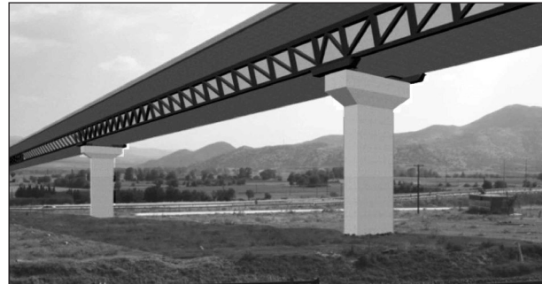
Bild 119: Externe Fachwerkstruktur zur Adaption des Längssystems
