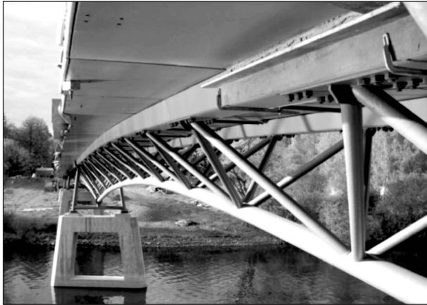
Bild 43: Gärtnersplatzbrücke, Ansicht im Bauzustand mit frischer Klebefuge (SCHMIDT, 2007)
