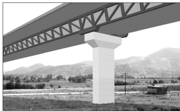
Bild 98: Exemplarische Lagerung des Ergänzungsfachwerks auf aufgeweiteten Stützenköpfen
