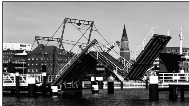
Bild 4: Funktionale Adaptivität – Klappbrücke im Hafen von Kiel (SCHLAICH, 2004)
