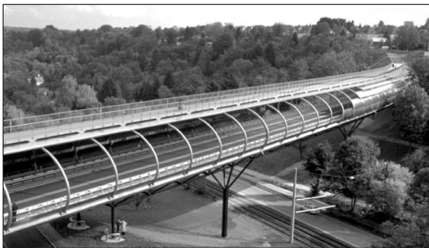
Bild 38: Nesenbachtalbrücke 1, Ansicht mit Lärmschutzverkleidung und Stahlrohrfachwerk (SCHLAICH, 2002)
