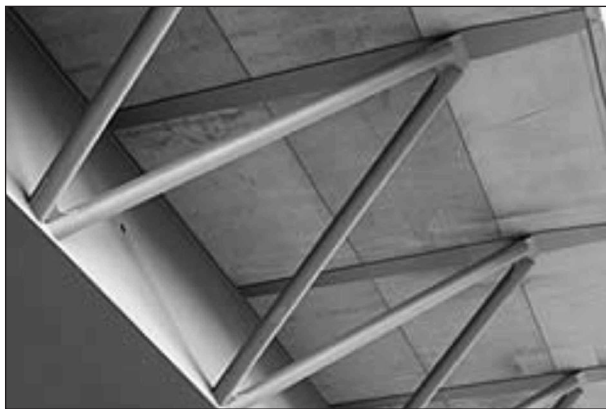
Bild 44: Nesenbachtalbrücke 2, Stahlfachwerk zur Stützung der Kragarme, bvs-bw.com
