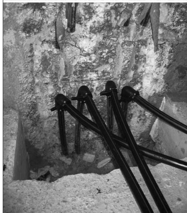
**Bild 54:** Ausleitung der Absorberleitungen im Bodenplattenbereich einer Energieschlitzwand. Oben: Freilegen der Anschlussstelle. Unten: Verbindung der Absorberleitungen mittels Elektroschweißmuffen
