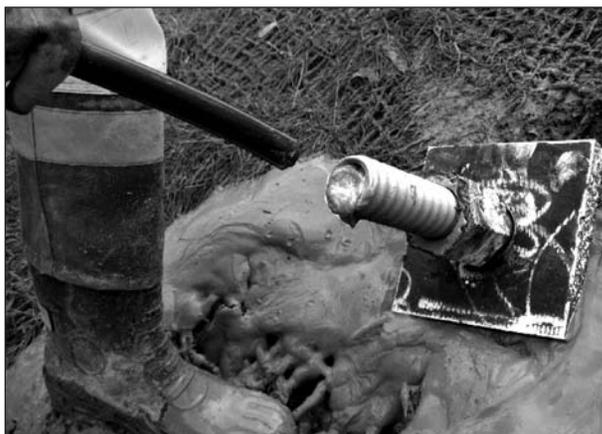
**Bild 8:** Herstellung eines Energieankers [29]
