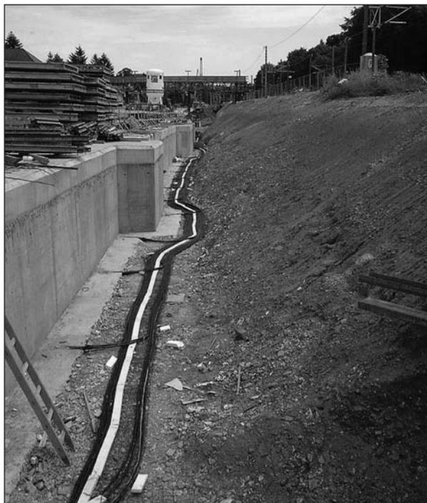
**Bild 48:** Tunnel in offener Bauweise mit Ausleitung der Absorberleitungen im Kopfbereich. Die Absorberleitungen werden seitlich des Deckels bis zum Erdwärmeverteiler geführt
