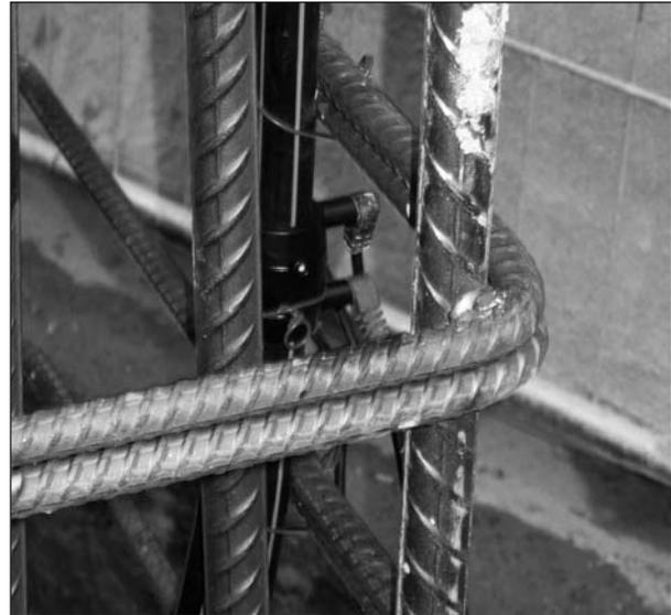
**Bild 40:** Elektroschweißmuffe zur Verbindung von PE-HD-Rohren im Zuge des Bewehrungsstoßes eines Schlitzwandelementes
