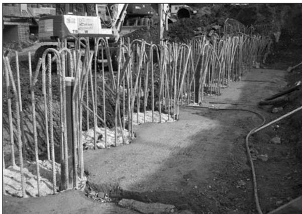
**Bild 50:** Ausleitung der Absorberleitungen im Kopfbereich der Bohrpfähle. Die Absorberleitungen werden in der Bau-phase durch entsprechende Schutzrohre geschützt
