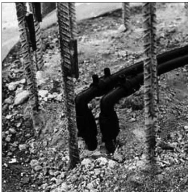
**Bild 53:** Ausleitung der Absorberleitungen im Kopfbereich eines Energiepfahls. Verbindung der Absorberleitungen mittels Elektroschweißmuffen
