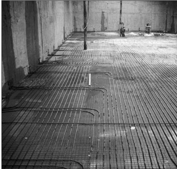
**Bild 49:** Tunnel in offener Bauweise mit Ausleitung der Absorberleitungen im Bodenplattenbereich. Die Absorberleitungen werden unterhalb der Bodenplatte verlegt und an einer zentralen Stelle durch die Bodenplatte ins Tunnelinnere geführt
