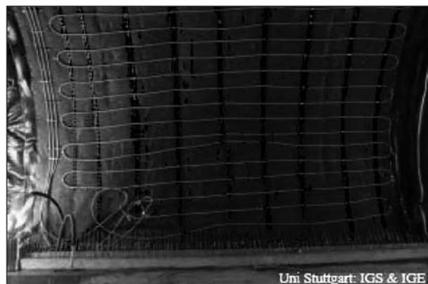
**Bild 7:** Einbau des Energievlieses in einem Testabschnitt des Fasanenhofunnels in Stuttgart [18]
