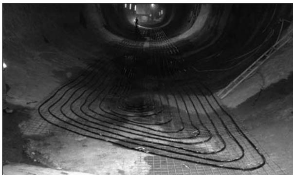
**Bild 9:** Beispiel einer absorberbelegten Tunnelsohle bei geschlossener Tunnelbauweise
