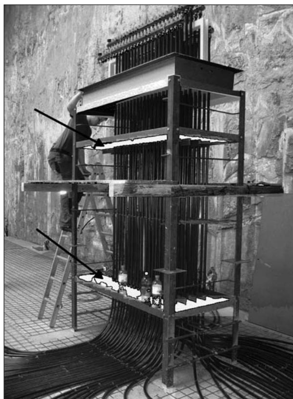
**Bild 55:** Beispiel einer wasserdichten Durchführung der Absorberleitungen durch die Bodenplatte nach dem System Rascor. Die Abdichtung erfolgt in zwei Ebenen, die anhand der weißen Schaumkörper (s. Pfeile) erkennbar sind. Die Bodenplatte reicht von der Sohle bis zum grauen Kasten. Darüber ist bereits der Verteilerblock installiert
