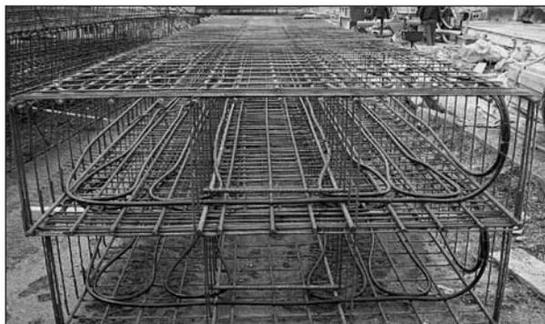
Bild 13: Beispiel einer Energieschlitzwand
