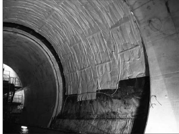
**Bild 43:** Beispiel einer Gewölbebelegung mit Energievliesbahnen
