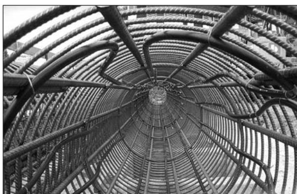
Bild 14: Beispiel eines Energiepfahles
