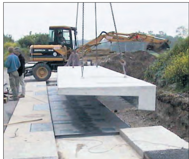
Bild 5: Einheben der 12-m-Kappe
