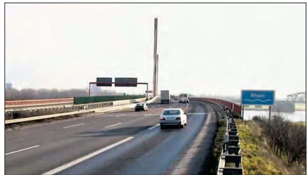
Bild 9: Übergang Strecke – Brücke
