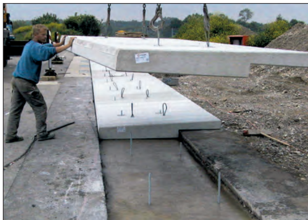
Bild 19: Einheben der Stahlbetonelemente außerhalb des Messbereichs auf das Streifenfundament
