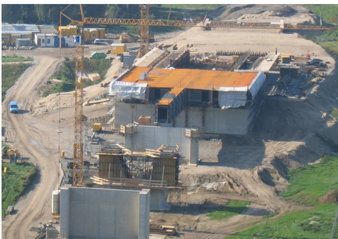
Abb. 6. Taktschieben – Vorbau schnabel – Betonquerschnitt
