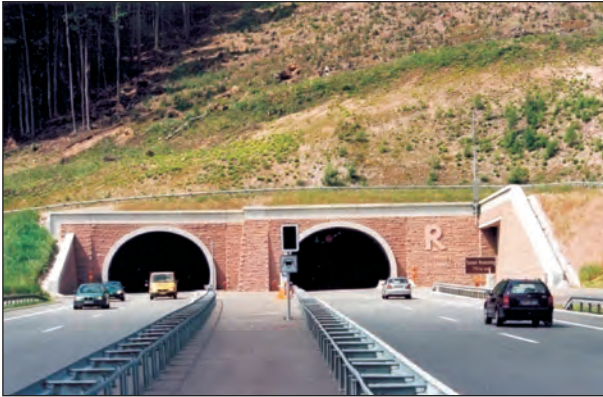
Bild 3: Portal Tunnel Rennsteig
