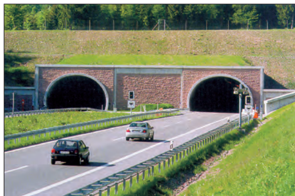
Bild 17: Portal Tunnel Hochwald
