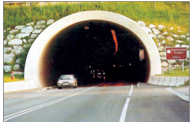
Bild 30: Portal Grenz Tunnel Füssen
