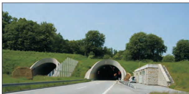
Bild 36: Portal Tunnel Königshainer Berge
