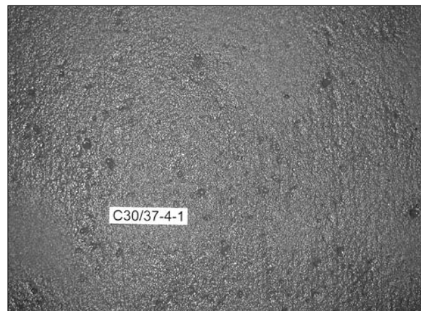
Bild 22: Grundierung 1 mit Abstreung auf Beton C30/37 mit großer Rautiefe (Walzenräsens)
