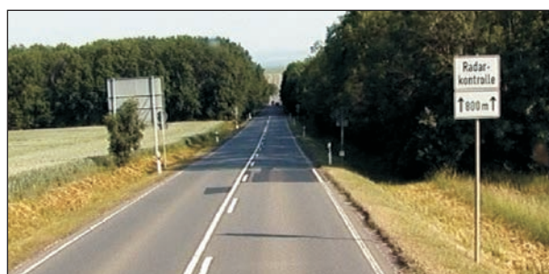
Bild 1.5-4: Hinweis Radarkontrolle B 247 (Quelle: ZEB 2008)
