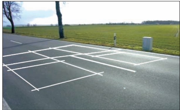
Bild 2.2-1: Querschnitt mit Doppelinduktionsschleifen (nachgezeichnete Schleifenlage)
