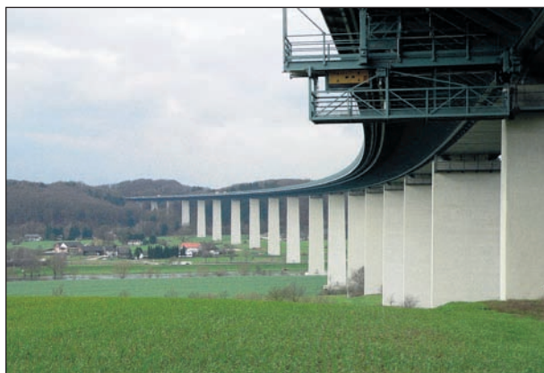
Bild 11: Ruhrtalbrücke Mintard – Bauwerksansicht
