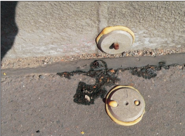
Bild 6: Messmarken für jahreszyklische Fugenbewegungen
