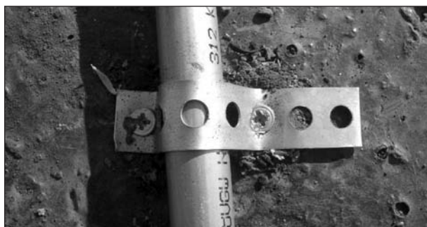
Bild 40: Befestigung der Rohre durch zugeschnittenes Lochband und Schrauben
