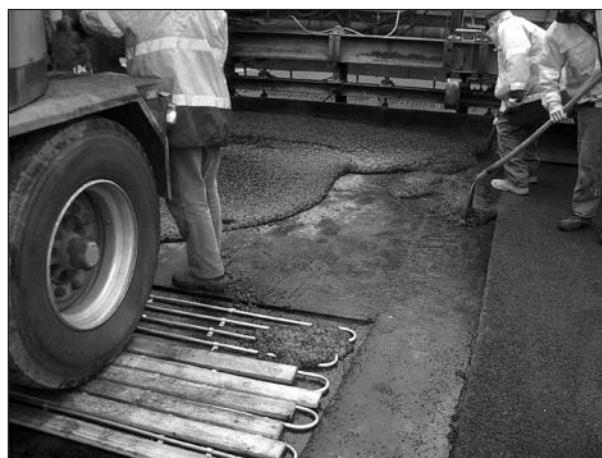
Bild 116: Einbau der Deckschicht mit Fertiger im Bereich der Rohre
