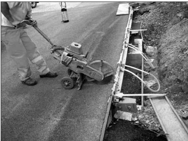
Bild 90: Fräsen der Fugen für die Temperaturfühler
