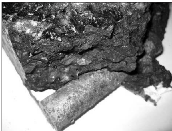
Bild 26: Rohr PE-Xa mit Aluminiumummantelung-Verbund zwischen Gussasphalt und Rohr (Draufsicht)
