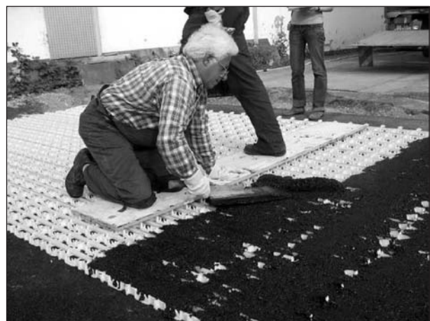
Bild 84: Asphaltieren der Zwischenschicht
