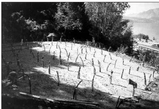
Bild 14: Sondenfeld vor Aufbringen der Humusschicht (SERSO)
