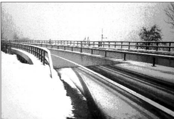
Bild 5: Brücke am Thuner See (CH), Wirkung der Temperierung
