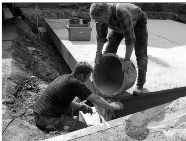
Bild 79: Einbetonieren der Fundament-Anschlüsse
