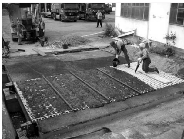
Bild 86: Stahlstäbe, um Verformung der Matten zu vermindern
