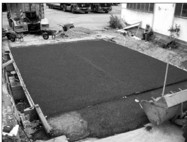
Bild 88: Fertig gestellte Testbrücke
