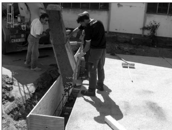
Bild 80: Betonieren der Stützmauern an den Überfahrten
