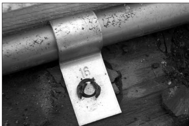
Bild 41: Befestigung der Rohre durch Metallhalter und durch „Festschießen“
