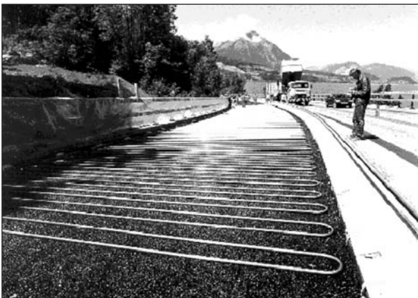
Bild 4: Brücke am Thuner See (CH), Projekt „Serso“, Einbau der Rohrregister
