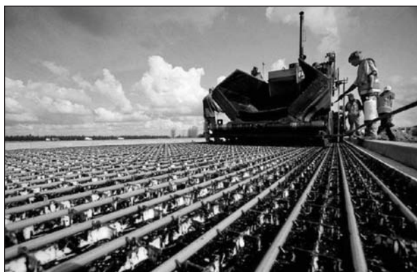
Bild 7: Walzasphalt-Straßenheizung (NL)
