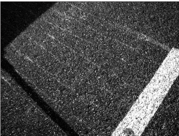
Bild 118: Parallele Lage der Rohre nach dem Einbau des Gussasphaltes
