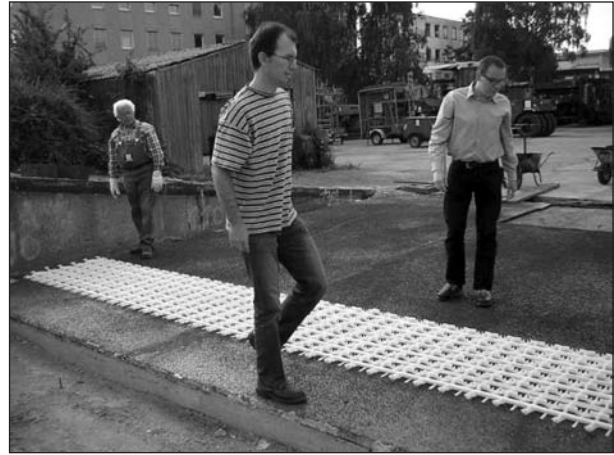
Bild 82: Positionieren der Temperierungs-Module
