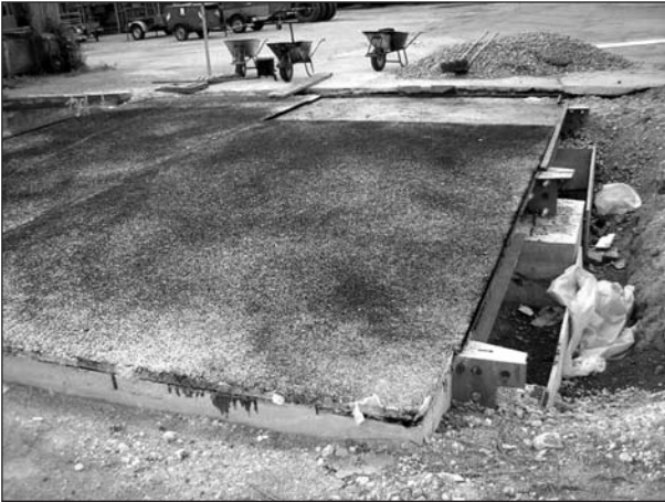
Bild 81: Fertige Testbrücke mit Pufferschicht und 1. Asphalt-schicht
