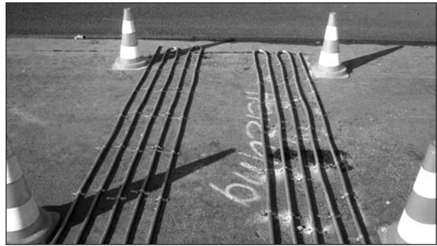
Bild 112: Eingebaute Rohre im ersten Abschnitt
