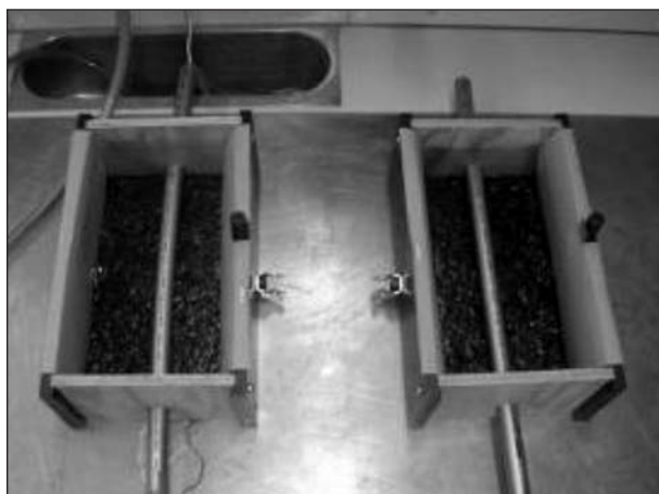
Bild 23: Asphalt einbau – Rohre PE-Xa ohne Aluminiumummantelung (mit und ohne Wasserkühlung)
