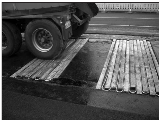
Bild 115: Einbau der Deckschicht – Anlieferung des Gussasphaltes
