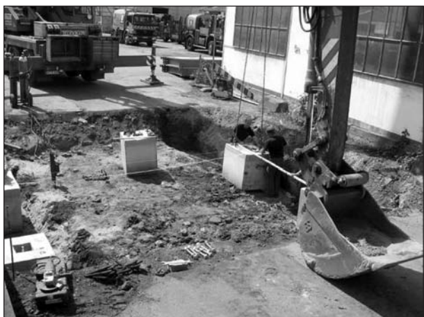
Bild 76: Aufstellen der Brücken-Fundamente (Beton-Fertigteile)
