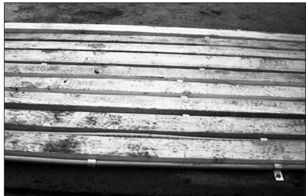
Bild 113: Eingebaute Rohre im zweiten Abschnitt
