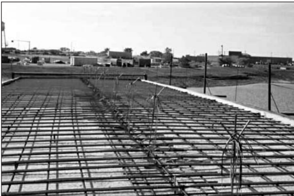
Bild 8: Smartbridge – vor dem Betonieren der Fahrbahnplatte
