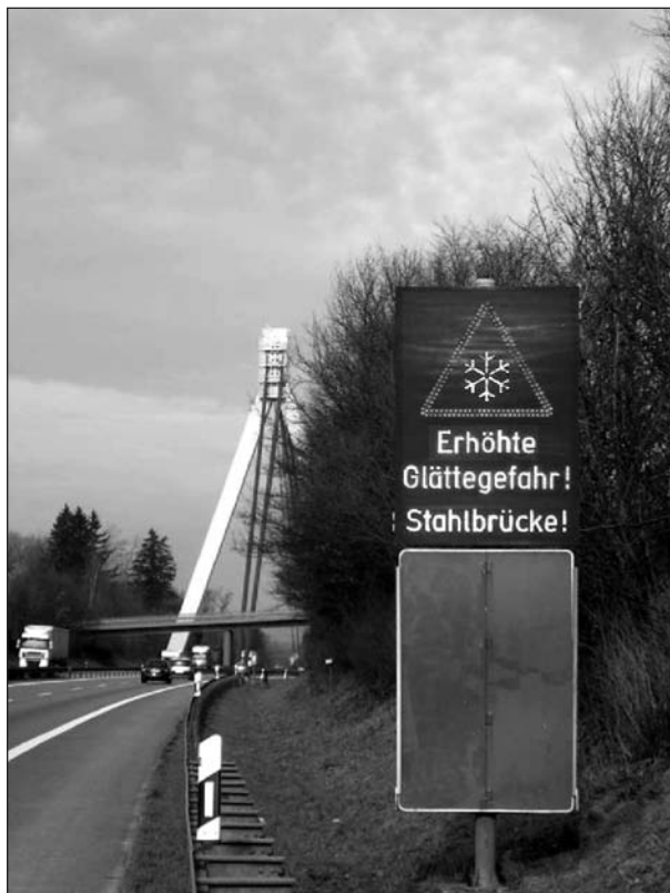
Bild 1: Glättegefahr auf Stahlbrücke – Talbrücke Obere Argen
