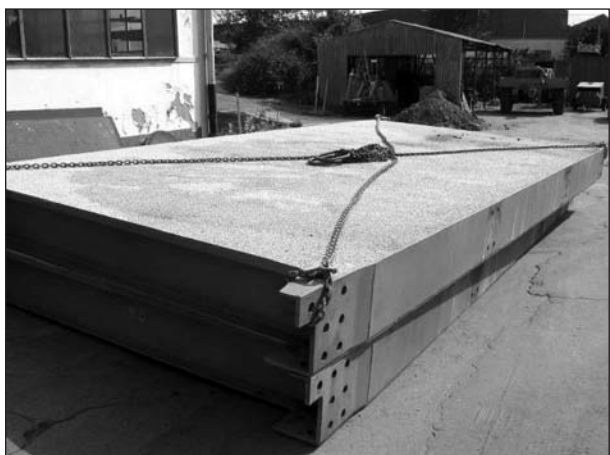
Bild 77: Grundierte Stahlbrückenmodule
