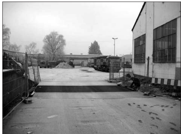
Bild 97: Foto von der Testbrücke, vom 20.12.2007
