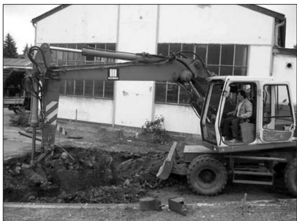
Bild 75: Auskoffern des Luftraumes
