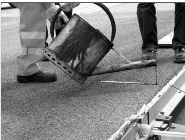
Bild 91: Bitumenverguss eines Temperaturfühlers
