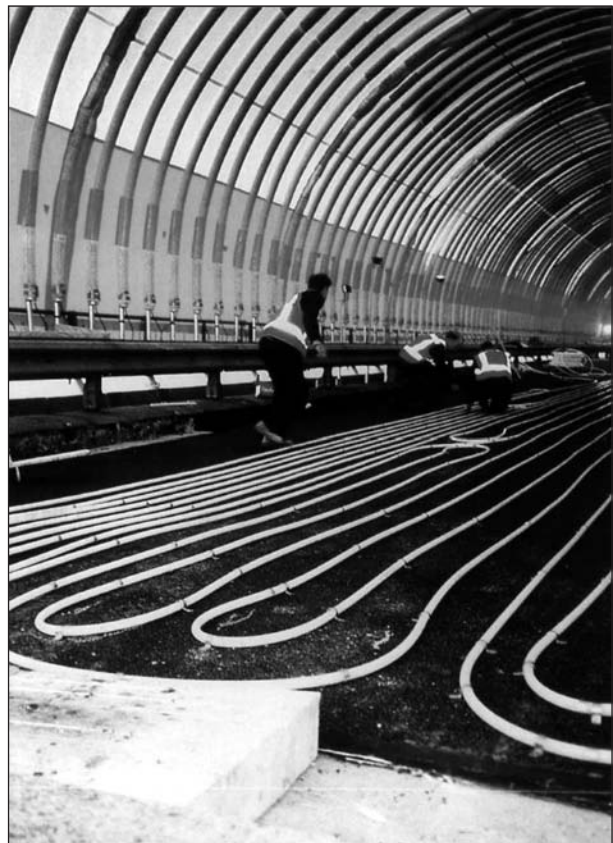
Bild 6: Erstellung der Fahrbahntemperierung Haringvliet-Sperrwerk (NL)
