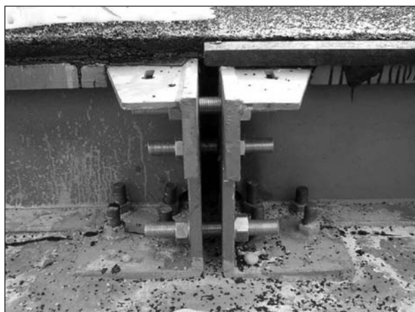
Bild 78: Schraub-Verbindung der zwei Module
