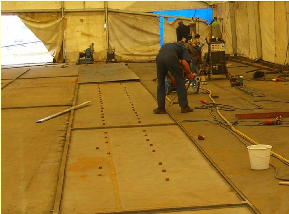
Positionieren eines Deckblechs
