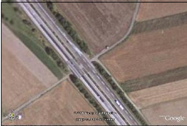
Bild 6: Bauwerk 1 im ÜB 1 aus Google bei einer Sichthöhe von 250 m
