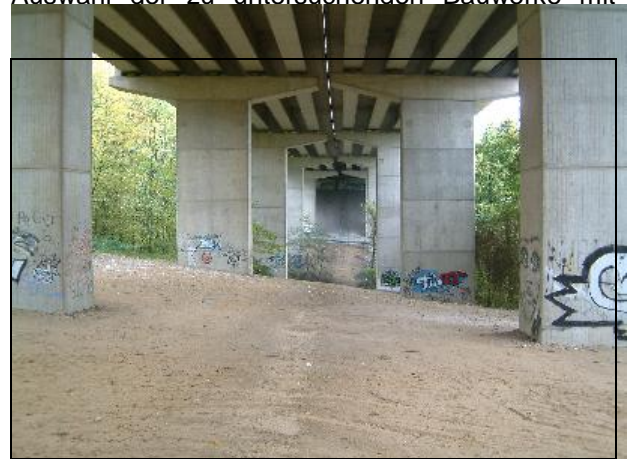
Bild 52: Untersicht von BW 1 im Zuge der A 59
