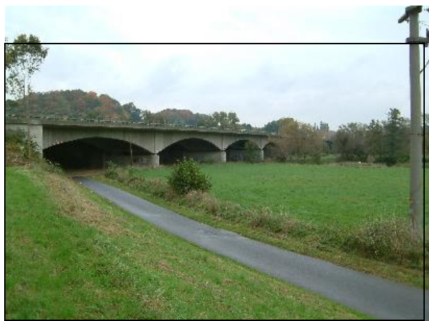
Bild 58: Teilansicht BW 4 mit Radweg im Vordergrund
