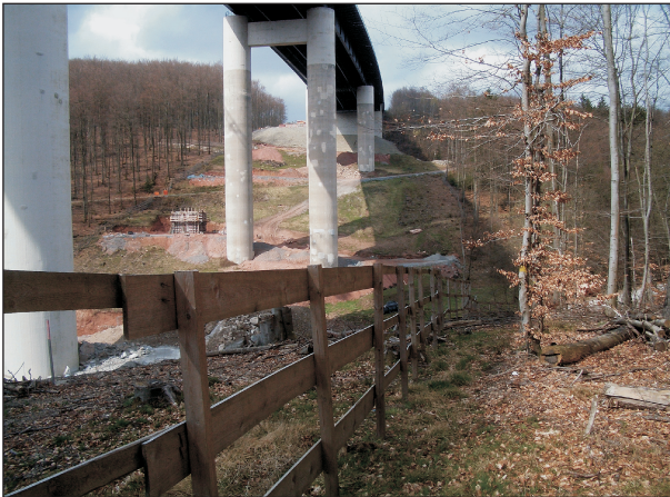
Bild 12: BAB A 3, Haseltalbrücke
