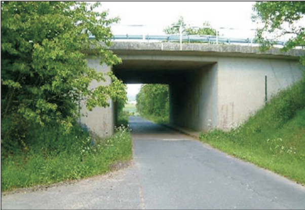
Bild 8: Überschneidungsbereich 4, Bauwerk 2 (ÜB4 BW2)
