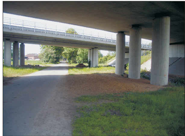
Bild 13: BAB A 2, Überbrückung von Gemeindestraße und Bach bei Barnke
