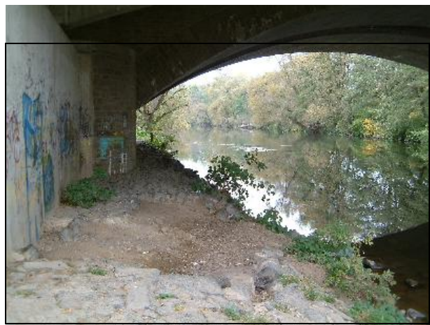
Bild 59: Uferstruktur unter dem Bauwerk von BW 4
