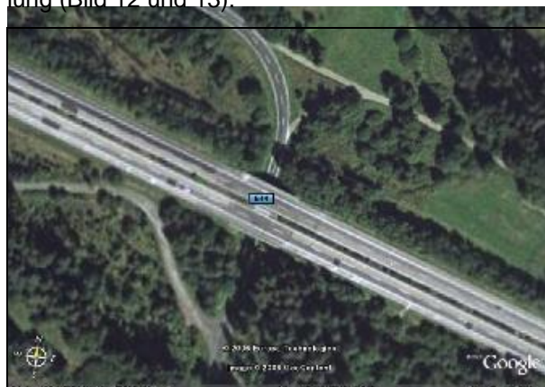
Bild 12: BW 3 aus Google Earth bei einer Sichthöhe von 260 m
