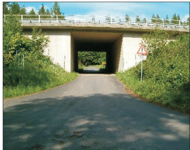
Bild 10: Überschneidungsbereich 4, Bauwerk 3 (ÜB4 BW3)
