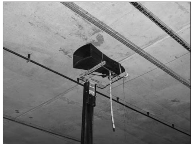
Bild 51: Montage mittig unter der Tunneldecke
