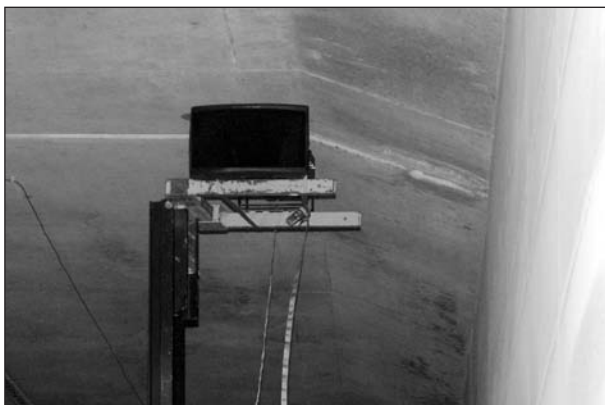
Bild 50: Montage seitlich unter der Tunneldecke
