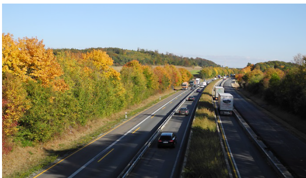
Bild 6-10: Blick von der Übersichtskamera für die Messungen 8 und 9 in Richtung Osten
