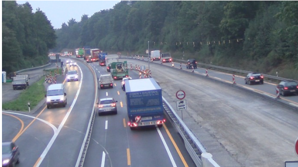
Bild 6-4: Blick von der Übersichtskamera für die Messung 3 in Richtung Süden
