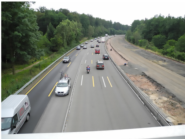
Bild 6-12: Blick von der Übersichtskamera für die Messungen 10 und 11 in Richtung Süden
