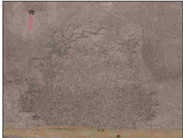
Bild 78: Fehlstelle nach der Betonage
