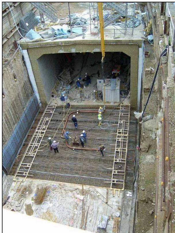
Bild 7: Probebetonage einer Sohlplatte aus SVB
