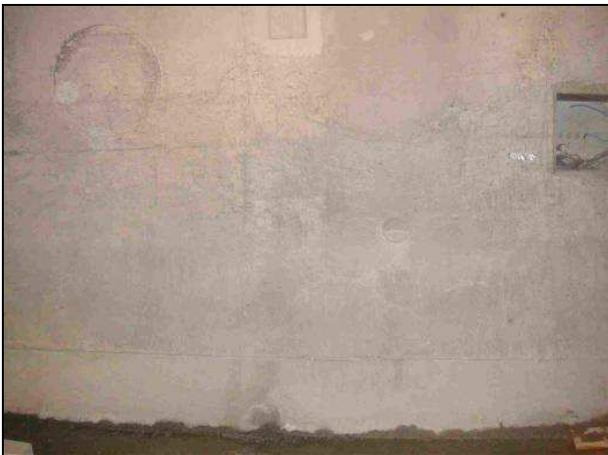
Bild 77: Lunkenbildung im Bereich negativer Krümmung
