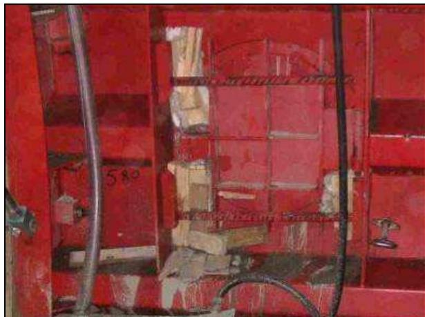
Bild 25: Zusätzliche Abdichtung eines Betonierfensters
