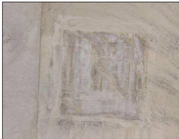
Bild 72: Falten der Gummimembran
