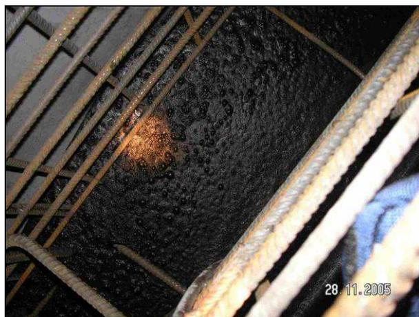
Bild 23: Ausbreiten und Entlüften des SVB in der Schalung
