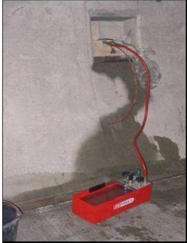
Bild 90: Aktivierung des Systems mit Handpumpe im FSB 59
