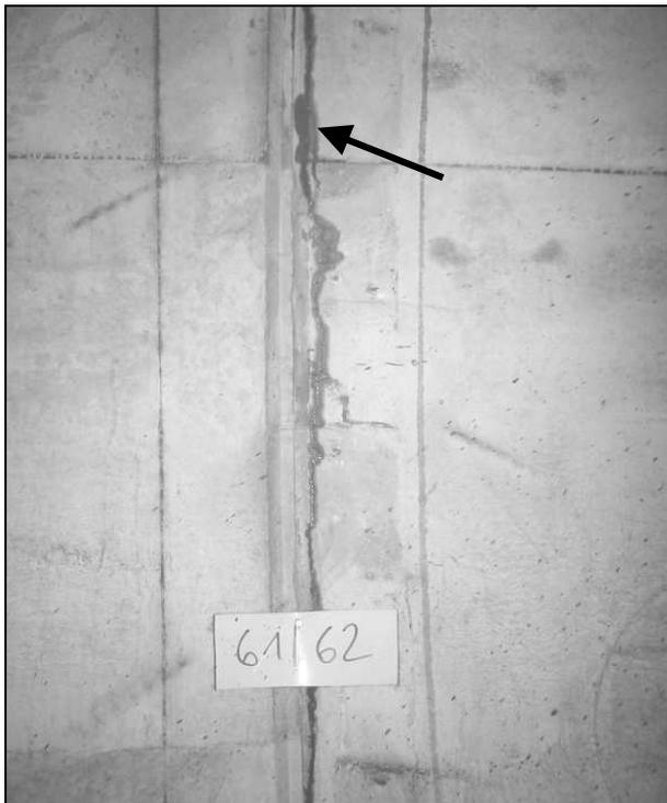
Bild 100: Wasserabfluss der in der Pressfuge zwischen FSB 62 und FSB 61 **X**
