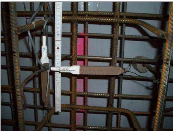
Bild 54: Beton-Dehnmessstreifen
