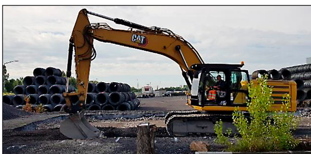
Bild 84: Verteilung des Erdbaustoffes im Probefeld
