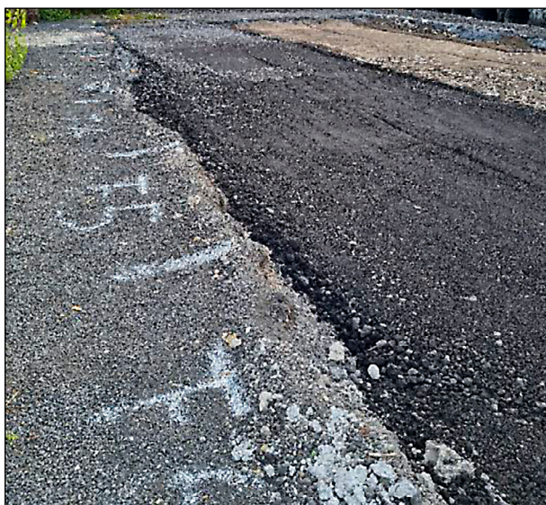
Bild 86: Verdichtetes Probefeld aus EOS
