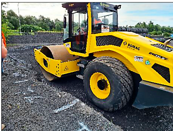
Bild 85: Verdichtung des Erdbaustoffes im Probefeld
