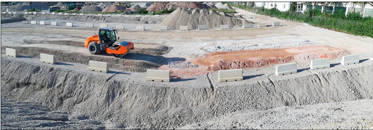
Bild 49: Probefelder aus natürlichem Rundkorn 0/45, RC B 0/16, RC Mix 0/22 und natürlichem Brechkorn 0/32 (ausgehend von oben links im Uhrzeigersinn) nach Beprobung
