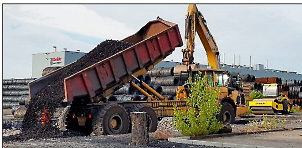
Bild 83: Ausbreitung des Erdbaustoffes im Probefeld
