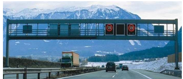
Abbildung 2-4: Beispiel für eine SBA ohne Seitenstreifenfreigabe [Autobahndirektion Südbayern]
