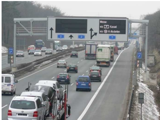
Abbildung 2-3: Beispiel für einen dWiSta-Querschnitt [http://www.move-info.de/vmz.html]
