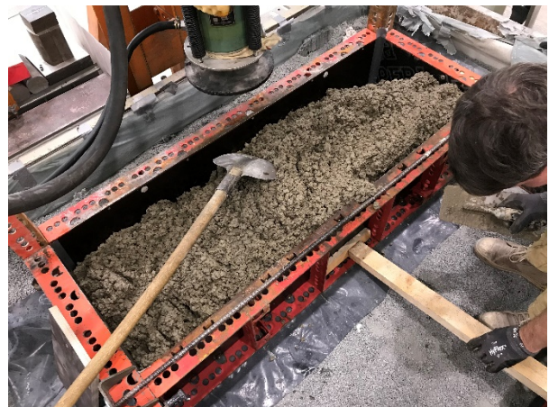
Abbildung 6.12: Einfüllen der ersten Charge Frischbeton in das geschalte Profil des Betonplattenstreifens und anschließende Verdichtung mittels Rüttelflasche
