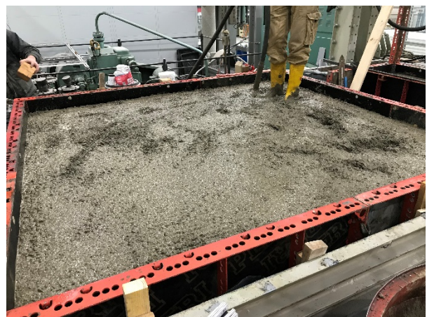
Abbildung 6.14: Verdichtung der Betonplatte mittels Rüttelflasche
