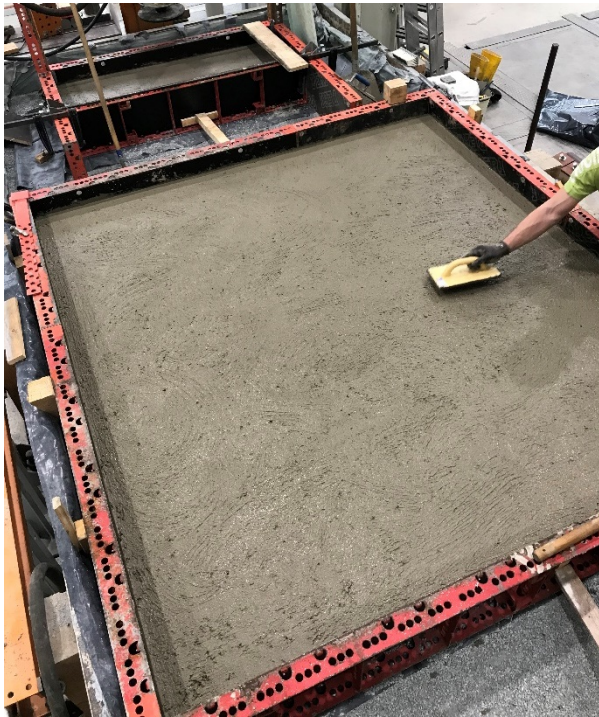
Abbildung 6.15: Oberflächenherstellung mittels Reibeblech
