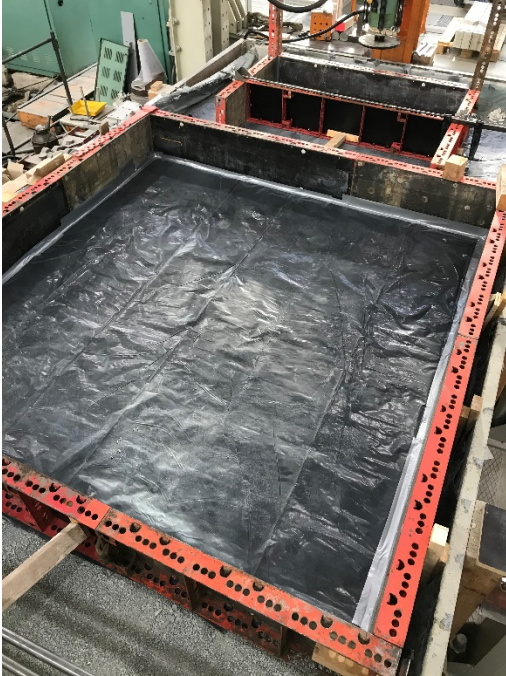
Abbildung 6.8: Geschaltete Rechteckprofile für die Betonage der großformatigen Betonprobekörper im großmaßstäblichen Versuchsstand
