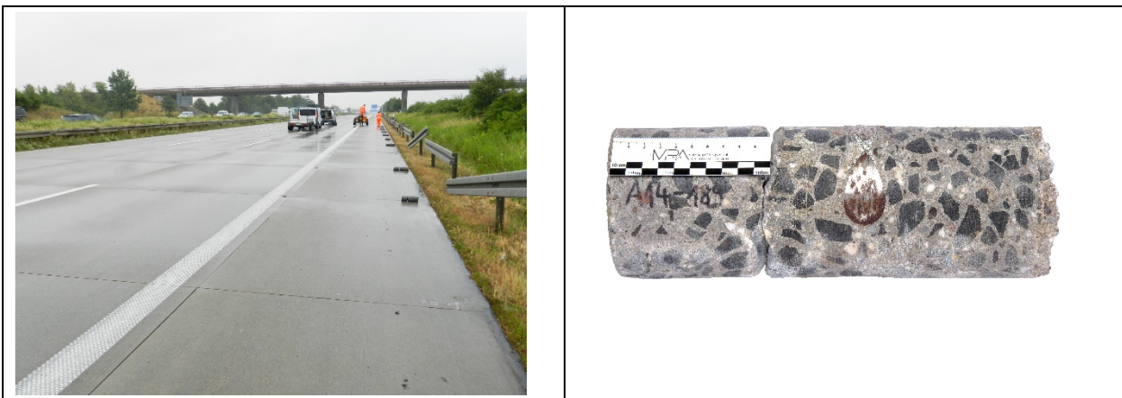
Bild 5-17: Übersichtsaufnahme der Bohrkernentnahme von Platte Nr. 189 bis Nr. 198 (links) und entnommener Bohrkern
