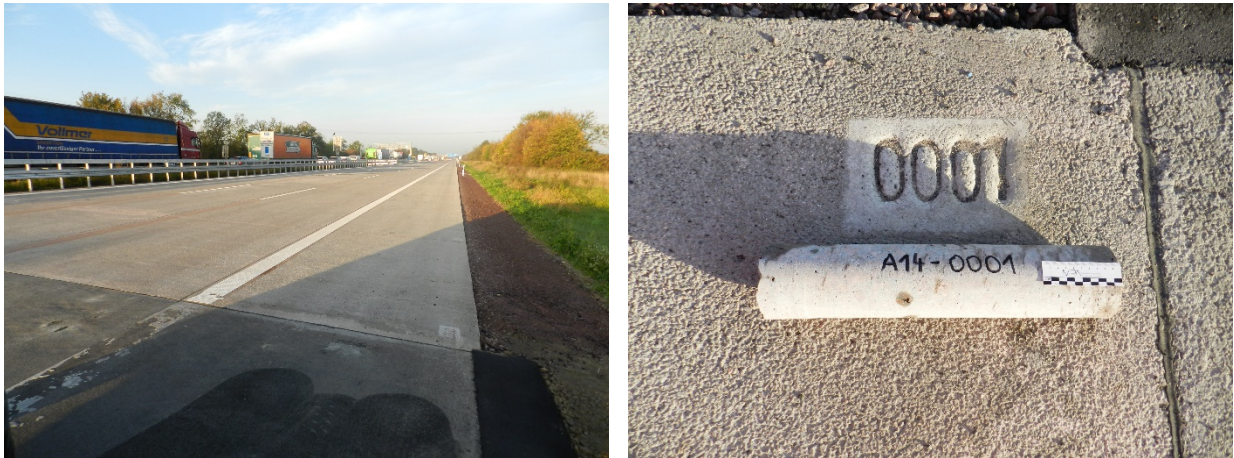
Bild 6-1: Baumaßnahme AS Leipzig – AD Schkeuditz BAB A14, Beginn des Streckenloses bei km 87+000 (links) und dazugehöriger Bohrkern bei Plattennummer 0001
