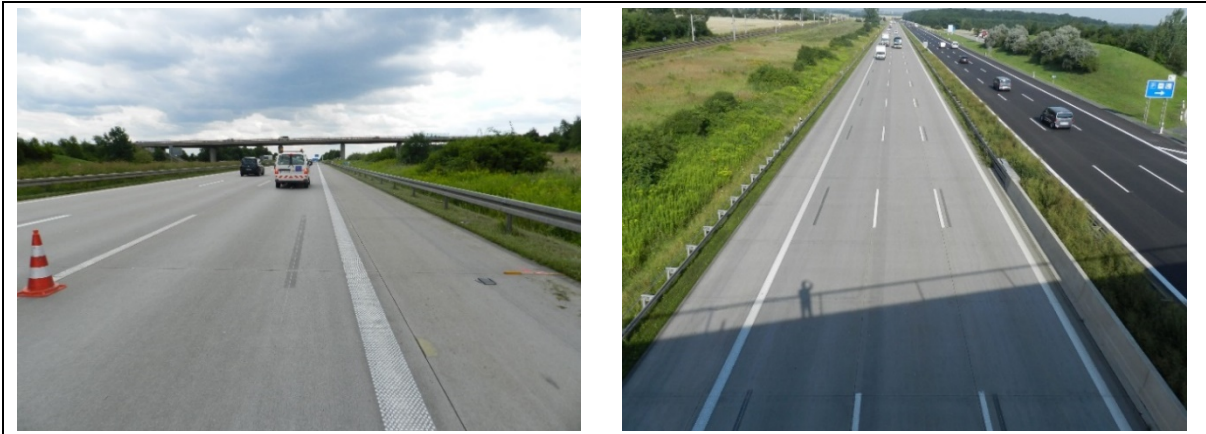
Bild 5-15: Übersichtsaufnahme zwischen den Autobahnanschlussstellen Leipzig-Nord und Leipzig-Mitte bei km 85+050 bis km 85+000 in Fahrtrichtung (links) und gegen die Fahrtrichtung (rechts)
