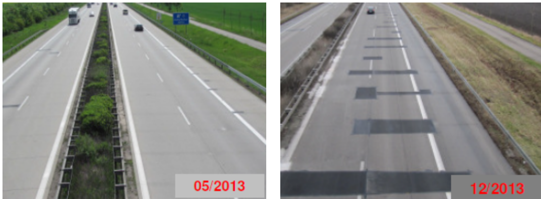
Bild 5-49: Rasante Schadensentwicklung an unbekannter Stelle der BAB A14 vor (links) und nach dem Sommer (rechts) (MARQUORDT 2014)
