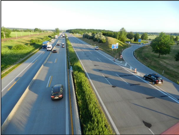
Bild 5-1: Übersichtsaufnahme zwischen den Autobahnanschlussstellen Leipzig-Mitte und Leipzig-Nord im untersuchten Streckenabschnitt bei km 85+735
