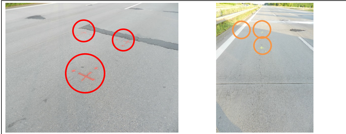
Bild 5-3: Übersichtsaufnahme Bohrkernentnahmestellen im HS (rote Markierung), Platten-Nr. 0260 (links) und im 2.ÜFS (gelbe Markierung), Platten-Nr. 0259 (rechts)
