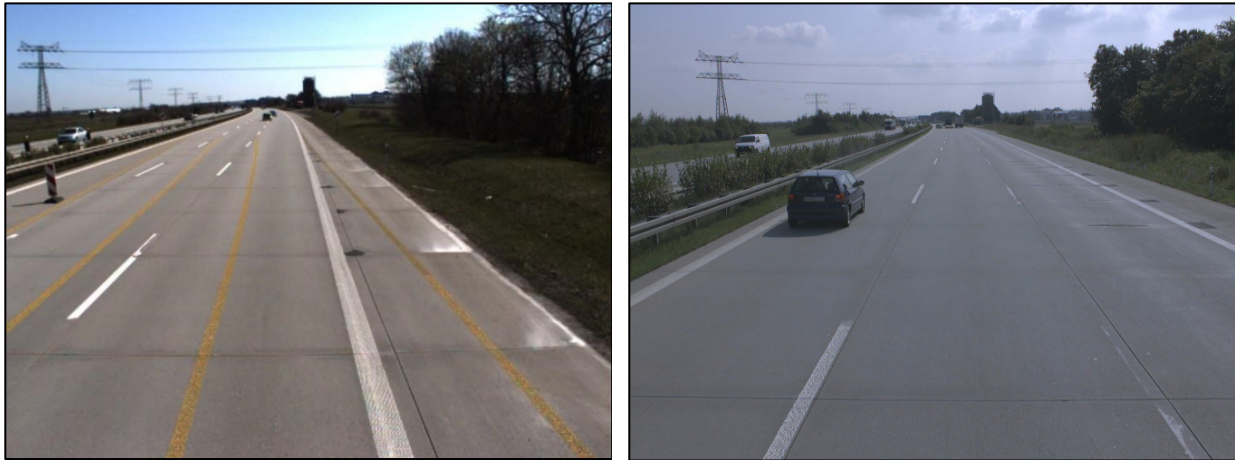
Bild 5-42: Gegenüberstellung geänderte Spurführung aufgrund einer Baustelle in den Jahren 2010 (links) und 2014 (rechts), RFB Süd bei km 90+400 (Bilder aus dem IT-ZEB-Server, HELLER Ingenieurgesellschaft mbH 2019)
