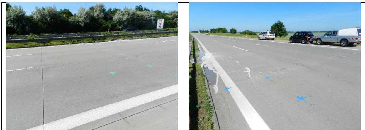
Bild A - 24: Übersichtsaufnahme Bohrkernentnahmestellen im HS, Platten-Nr. 0508 (links) und in der 2.ÜFS, Platten-Nr. 0508 (rechts)
