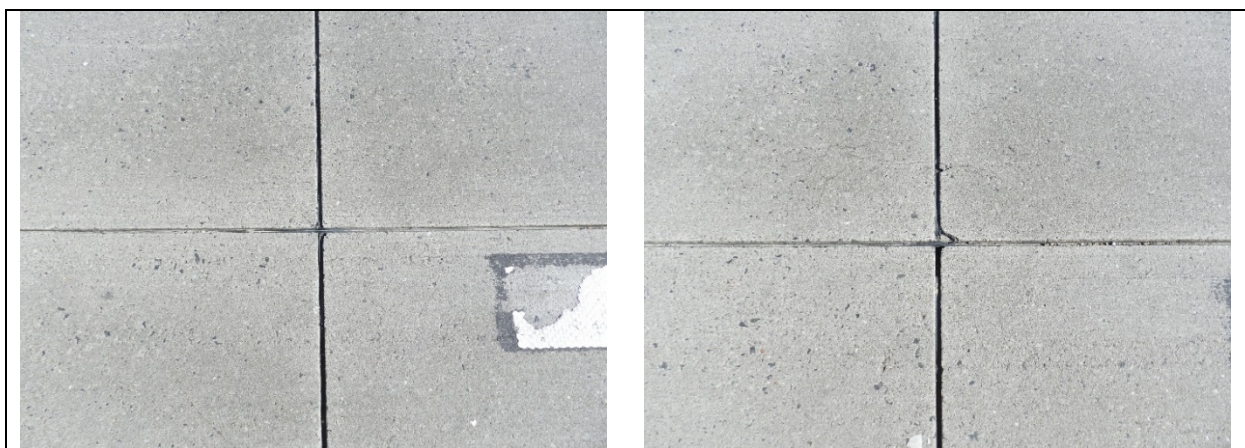
Bild A - 19: Fugenkreuze zwischen Plattenreihe 0507 und 0508 (linkes Bild: HF – 1.ÜFS, rechtes Bild: 1.ÜFS – 2.ÜFS)
