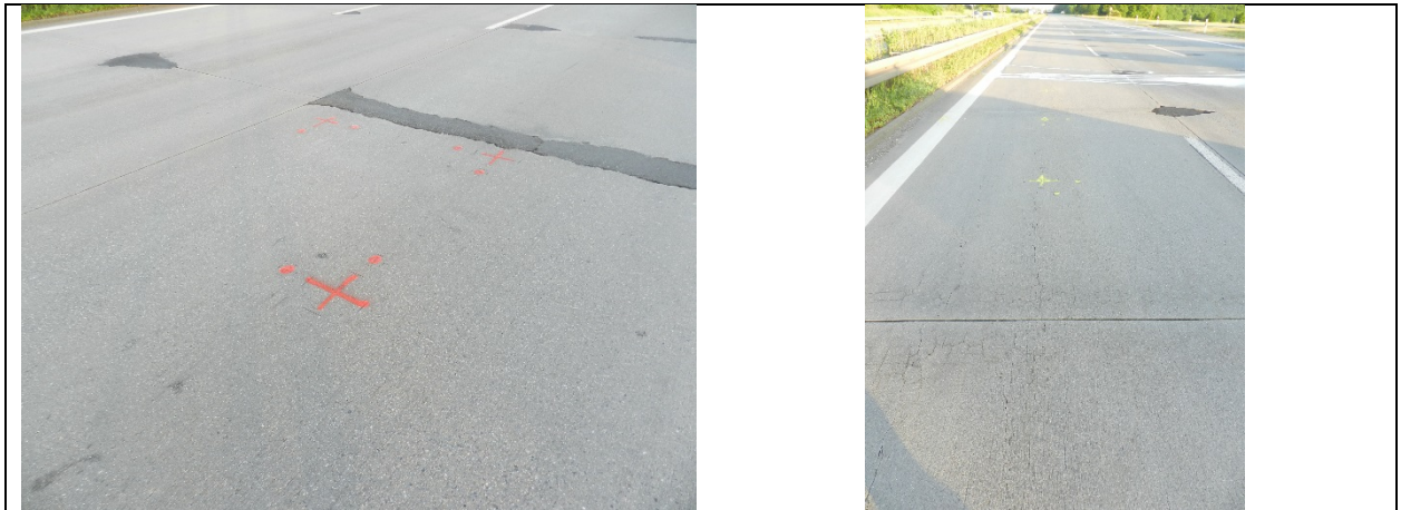
Bild A - 10: Übersichtsaufnahme Bohrkernentnahmestellen im HS, Platten-Nr. 0260 (links) und in der 2.ÜFS, Platten-Nr. 0259 (rechts)
