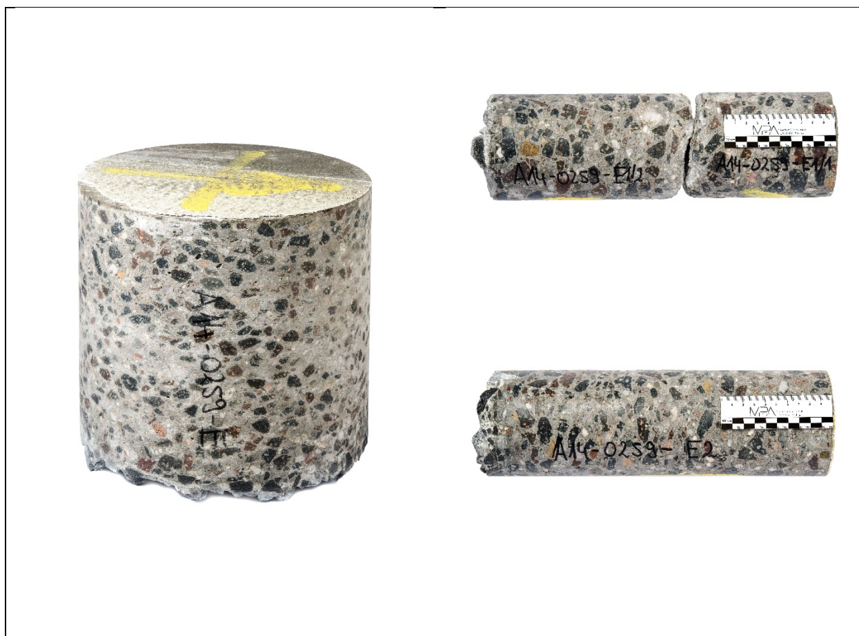
Bild A - 14: Bohrkerne aus 2.ÜFS, Entnahmestelle „Ecke“, Platten-Nr. 0259
