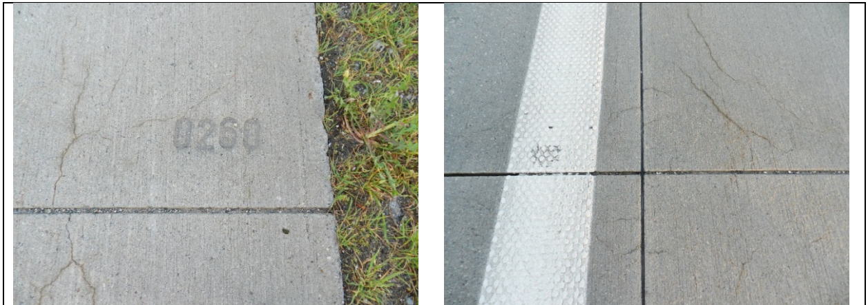
Bild A - 4: Querfuge und Fugenkreuz zwischen Plattenreihe 0259 und 0260 (linkes Bild: SS, rechtes Bild: SS – HF)
