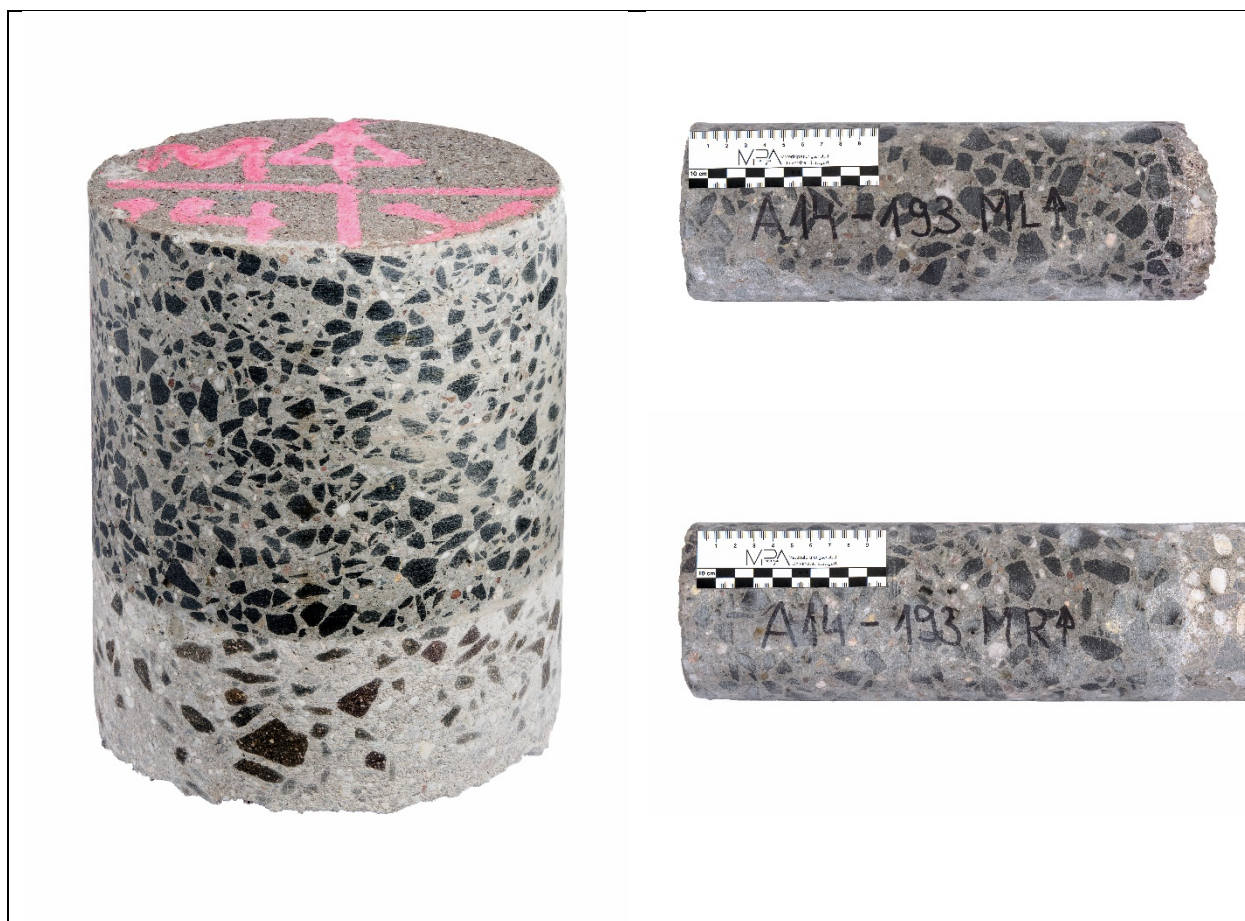
Bild A - 47: Bohrkerne Entnahmestelle HF „Plattenmitte“, Platten-Nr. 193
