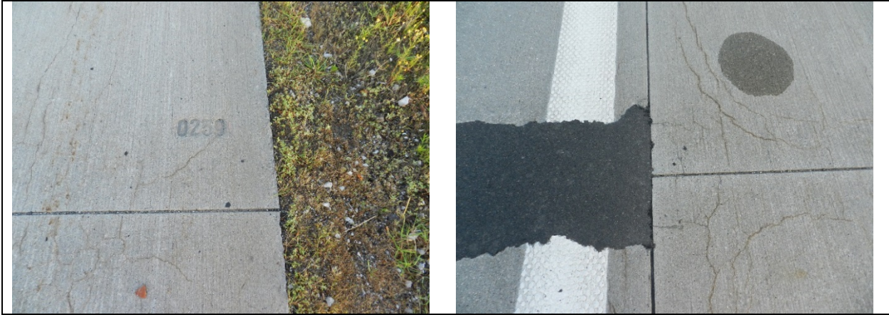
Bild A - 1: Querfuge und Fugenkreuz zwischen Plattenreihe 0258 und 0259 (linkes Bild: SS, rechtes Bild: SS – HF)
