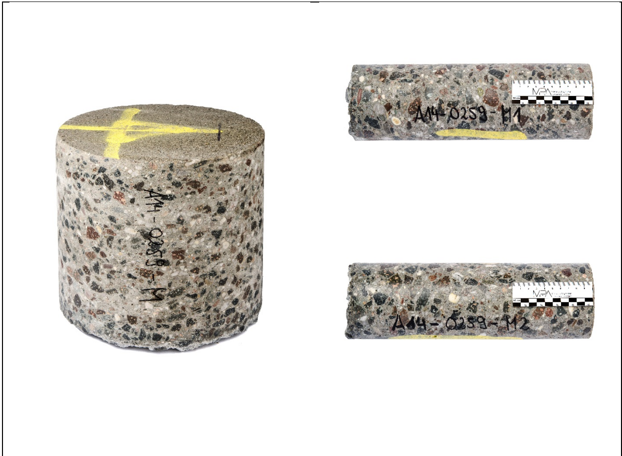
Bild A - 16: Bohrkerne aus 2.ÜFS, Entnahmestelle „Plattenmitte“, Platten-Nr. 0259
