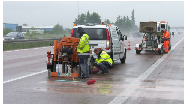
Bild 5.8: Bohrkernentnahme im ersten Fahrstreifen, hinten im Bild FWD-Messung
