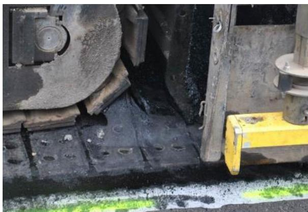
Bild 8: Lösen und teilweises abreißen des Vlieses bei der Überfahrt
