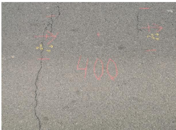
Bild 365: Bohrkerntnahmestellen Durchmesser 400mm L3079
