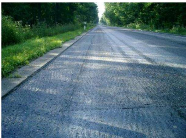
Bild 361: B70 Gefräste Unterlage vor Einbau der Asphaltteinlage bzw. Asphaltdeckschicht (Archivbild 2007, (Straßen.NRW, Bruno Tenhumberg))
