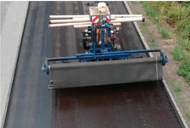
Bild 371: L608 Einlageneinbau
