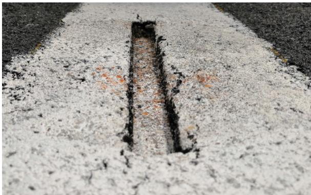
Bild 200: Verformung im Lastezugsbereich
