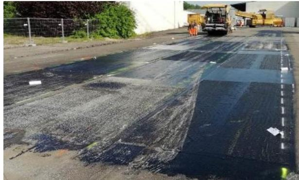
Bild 5: Probefeld vor Asphaltüberbau
