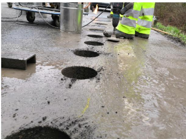
Bild 362: Bohrkernentnahme auf B70
