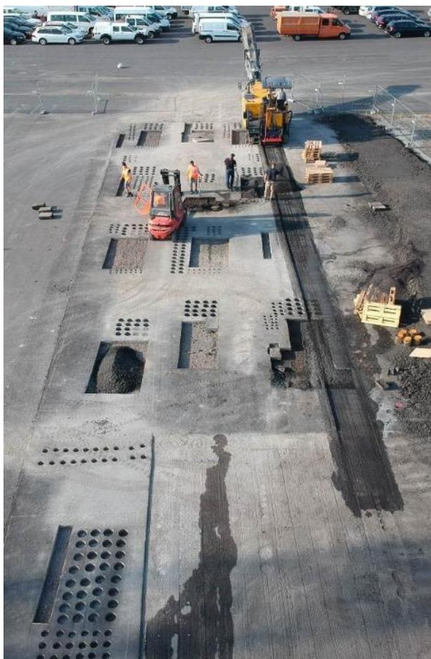
Bild 12: Probestrecke nach der Probenentnahme, während des Fräsens
