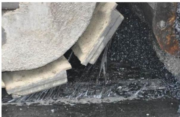
Bild 7: Überfahrt der angespritzten Fläche ohne Asphalt-Einlage
