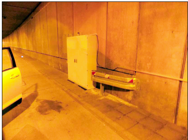
Bild 145: Schutzvorrichtung vor dem Messcontcontainer nach erfolgter Montage
