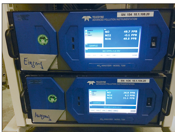
Bild 105: Exemplarische Messung der Stickoxidkonzentration der Demonstrator-Tunnelkassette während eines Testlaufs im Technikum
