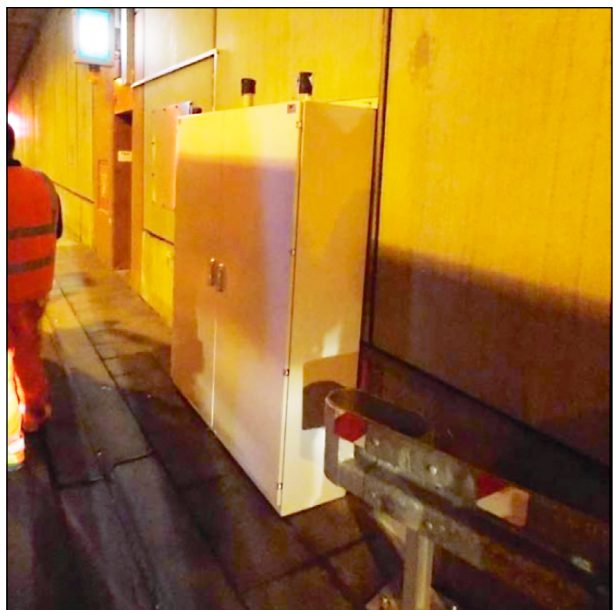
Bild 146: Erfolgte Installationsarbeiten der Messcontainer
