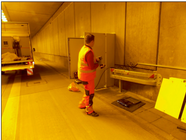
Bild 142: Installationsarbeiten an einem der drei Messcontainer mit angepasster Schutzvorrichtung im Tunnel Rudower Höhe
