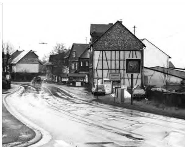
Bild 18: Standort der GWA am Ortseingang
