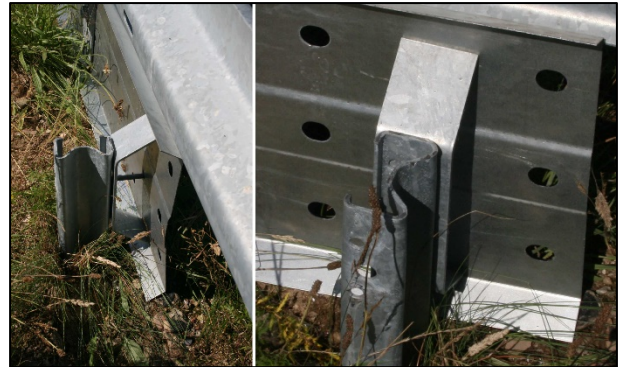
Bild 57 Endfixierung und Langlöcher im Stoßbereich des UFS
