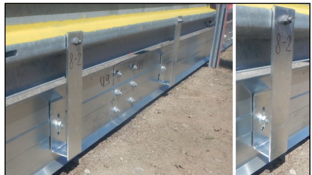
Bild 54 Anbringung des UFS mit zweiteiligen Bügeln
