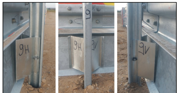
Bild 31 Zweiteiliges Deformationselement in der praktischen Umsetzung
