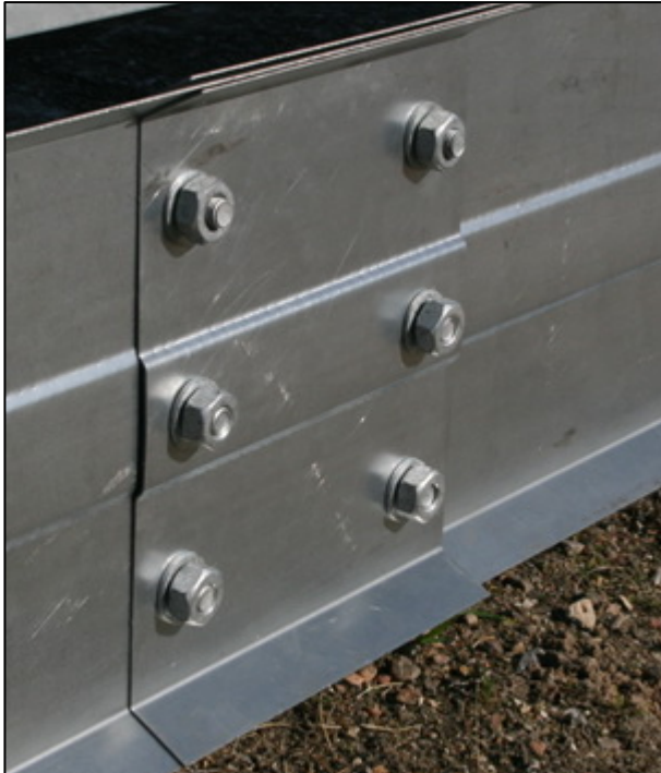
Bild 55 Vormontierter Stoßverstärker (Schrauben noch nicht festgezogen)
