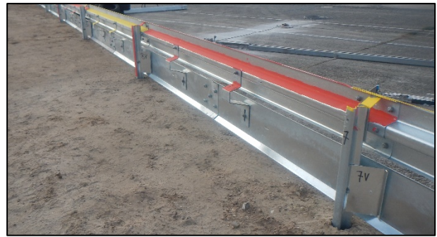
Bild 30 ESP 4.0 mit angebrachtem Unterfahrerschutz und Deformationselementen
