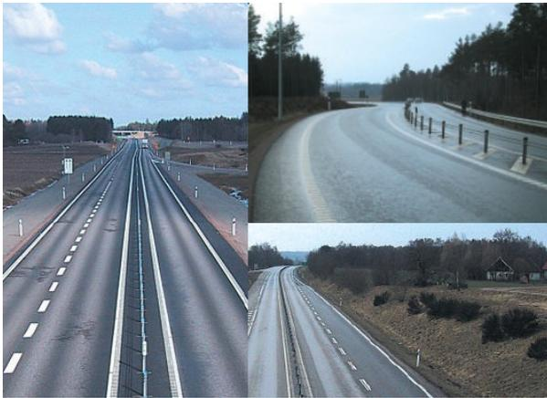
**Bild 2.12: 2+1 Straße in Irland mit Stahlseil-Barrieren (NRA, 2004)**
