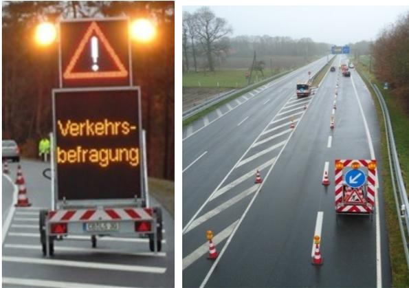
**Bild 4.27: Vorankündigung und Absperrbereich des Befragungsortes**
