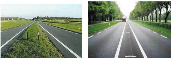
**Bild 2.8: Richtungstrennung von GOW- Straßen in den Niederlanden (C.R.O.W., 2008)**
