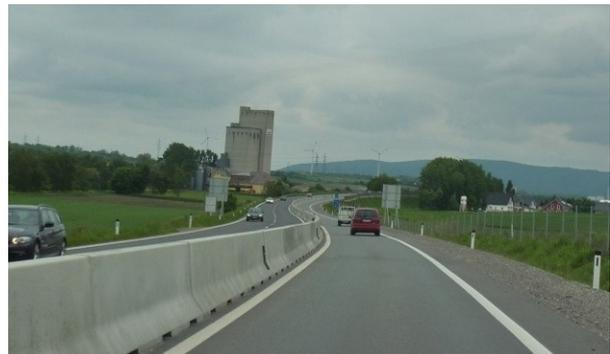
**Bild 2.27: S 3, einstreifige Richtung mit Seitenstreifen (eigenes Foto, 2010)**
