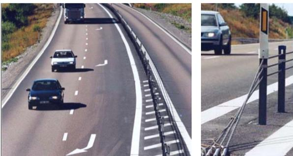
**Bild 2.11: 2+1 Straße in Schweden mit Stahlseil-Barrieren (TRB, 2003)**
