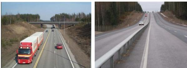
**Bild 2.13: 2+1 Straße in Finnland mit doppelter Fahrstreifenbegrenzung (TRB, 2003) bzw. baulicher Richtungstrennung (TIEHAL-**
