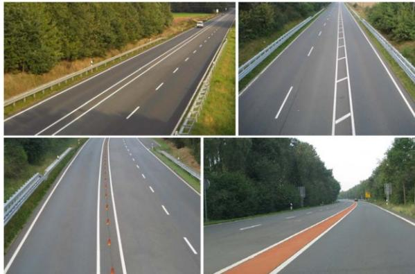
**Bild 4.45: Varianten der Fahrtrichtungstrennung Vorher (oben links) und Nachher (SCHOLLBACH, 2009)**
