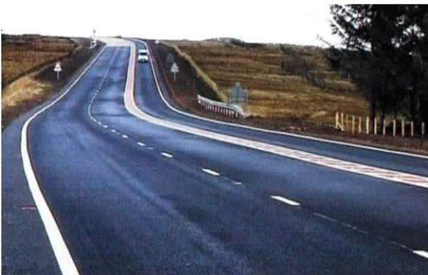
**Bild 2.15: 2+1 Straße in Großbritannien, mit roten verkehrstechnischen Mittelstreifen (C.R.O.W., 2008)**
