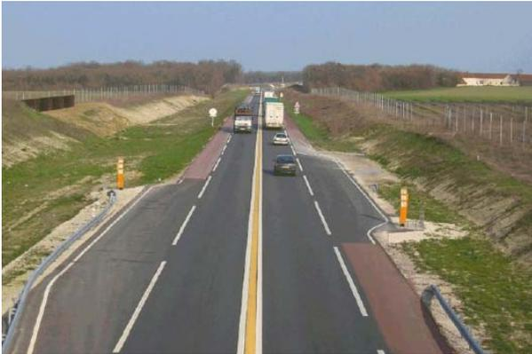
**Bild 2.14: Schnellstraße (Typ T) in Frankreich mit farbigen Mittelstreifen (RIPCORD ISEREST, 2006)**
