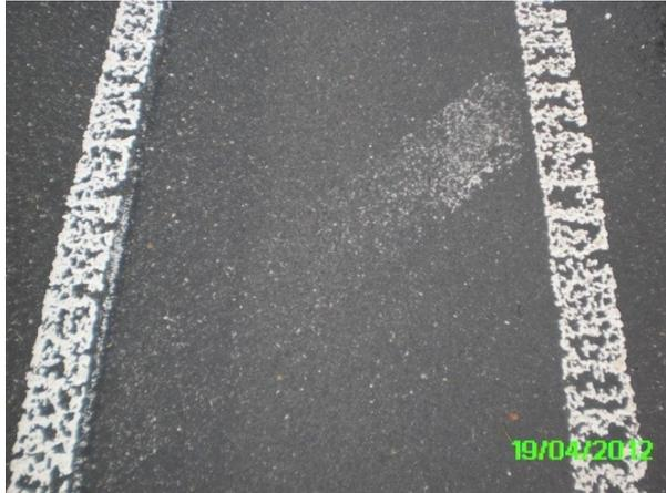
**Bild 5.42: Zustand der High Solid Farbe im Schrägstrichgatter, B 67**
