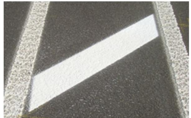
**Bild 5.41: Ausführung Schrägstrichgatter Untersuchungsstrecke B 67**
