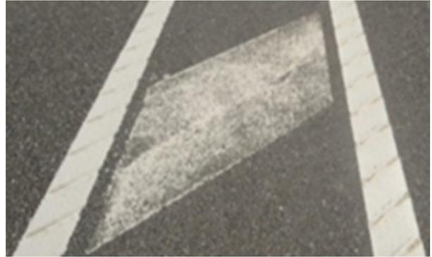
**Bild 5.40: Ausführung Schrägstrichgatter Untersuchungsstrecke B 33**
