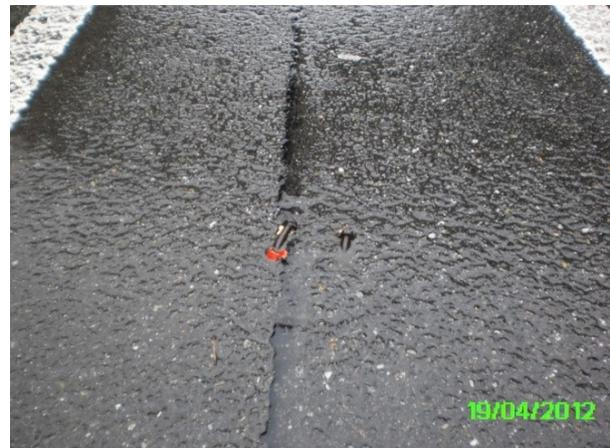
**Bild 5.44: Nägel nach Ausriss der Bischofsmützen, B 67**
