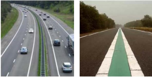
**Bild 2.7: Richtungstrennung von Stroomwegen in den Niederlanden (RIPCORD I SEREST, 2006)**
