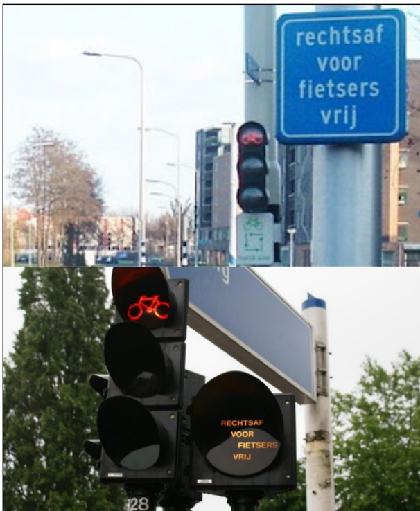
Bild 2.13: Beschilderung Rechtsabbiegen bei Rot für Rad Fahrende in den Niederlanden (TN, 2017; CROW, 2017)
