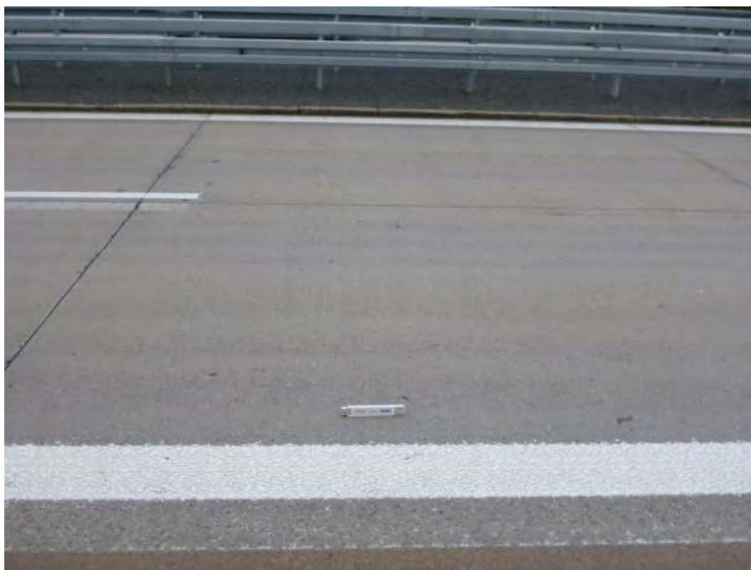
Bild 51 Baulos 5 (WE): Zustand der Fahrbahnoberfläche (1. und 2. FS): Keine sichtbaren Schäden
