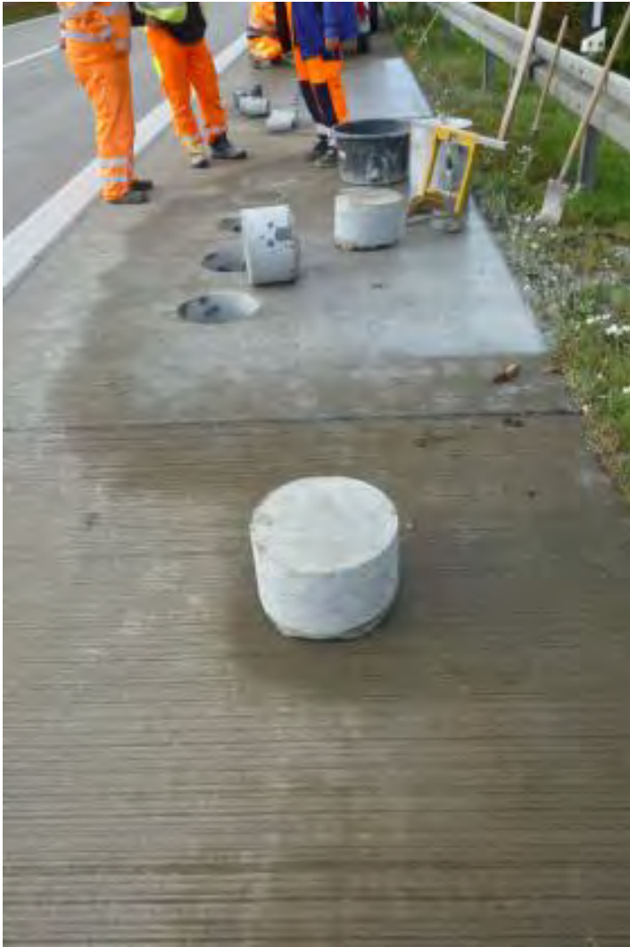
Bild 49 Baulos 4 (N2): Entnahme der Bohrkerne
