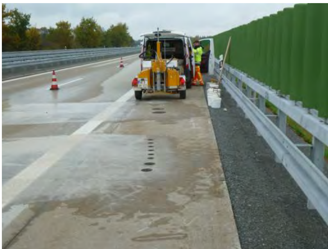
Bild 52 Baulos 5 (WE): Entnahme der Bohrkern
