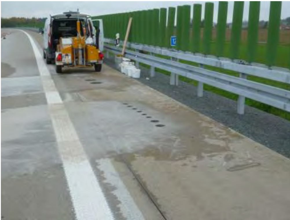
Bild 53 Baulos 5 (WE): Entnahme der Bohrkern
