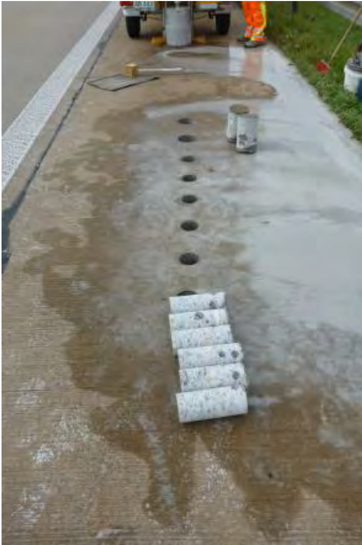
Bild 45 Baulos 3 (N1): Entnahme der Bohrkerne
