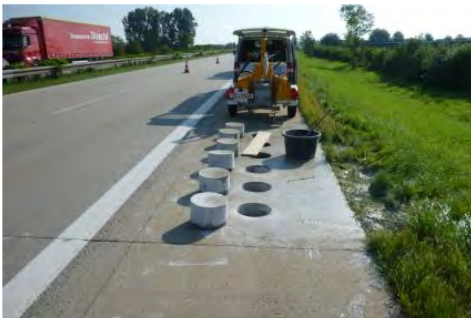
Bild 41 Baulos 2 (W): Entnahme der Bohrkern
