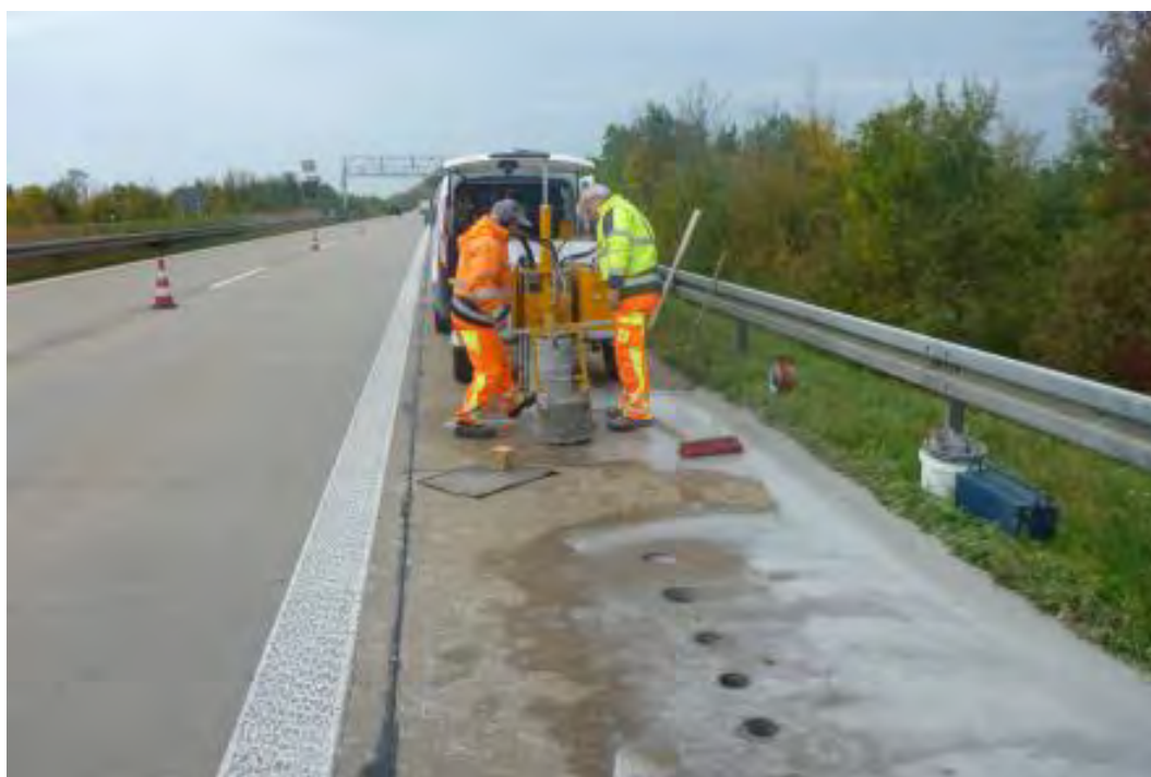
Bild 44 Baulos 3 (N1): Entnahme der Bohrkerne
