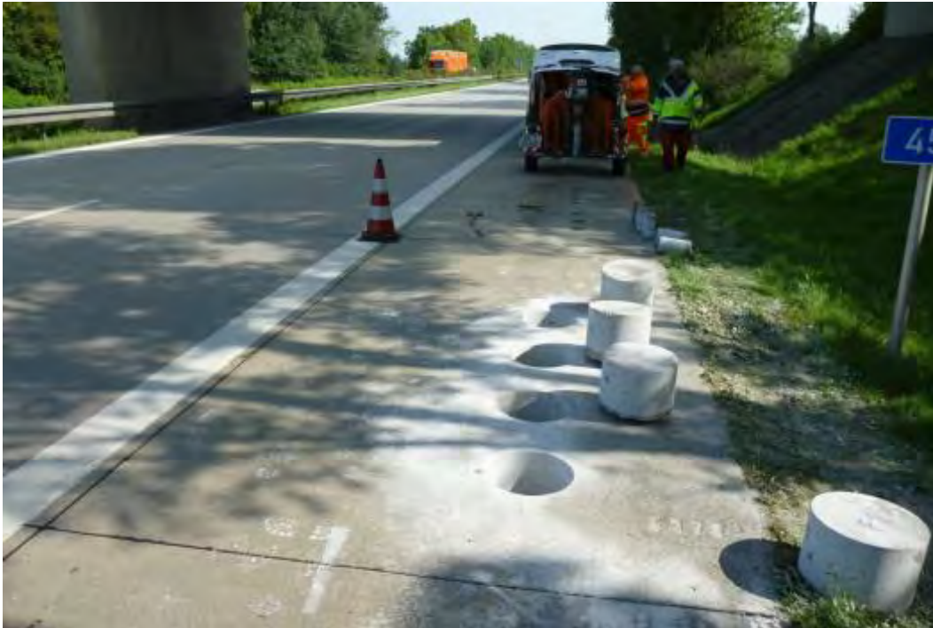
Bild 37 Baulos 1 (F): Entnahme der Bohrkerne
