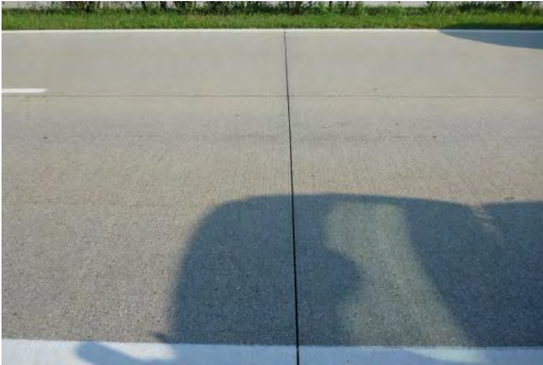
Bild 39 Baulos 2 (W): Zustand der Fahrbahnoberfläche (1. und 2. FS): Keine sichtbaren Schäden, Besenstrich quer sichtbar
