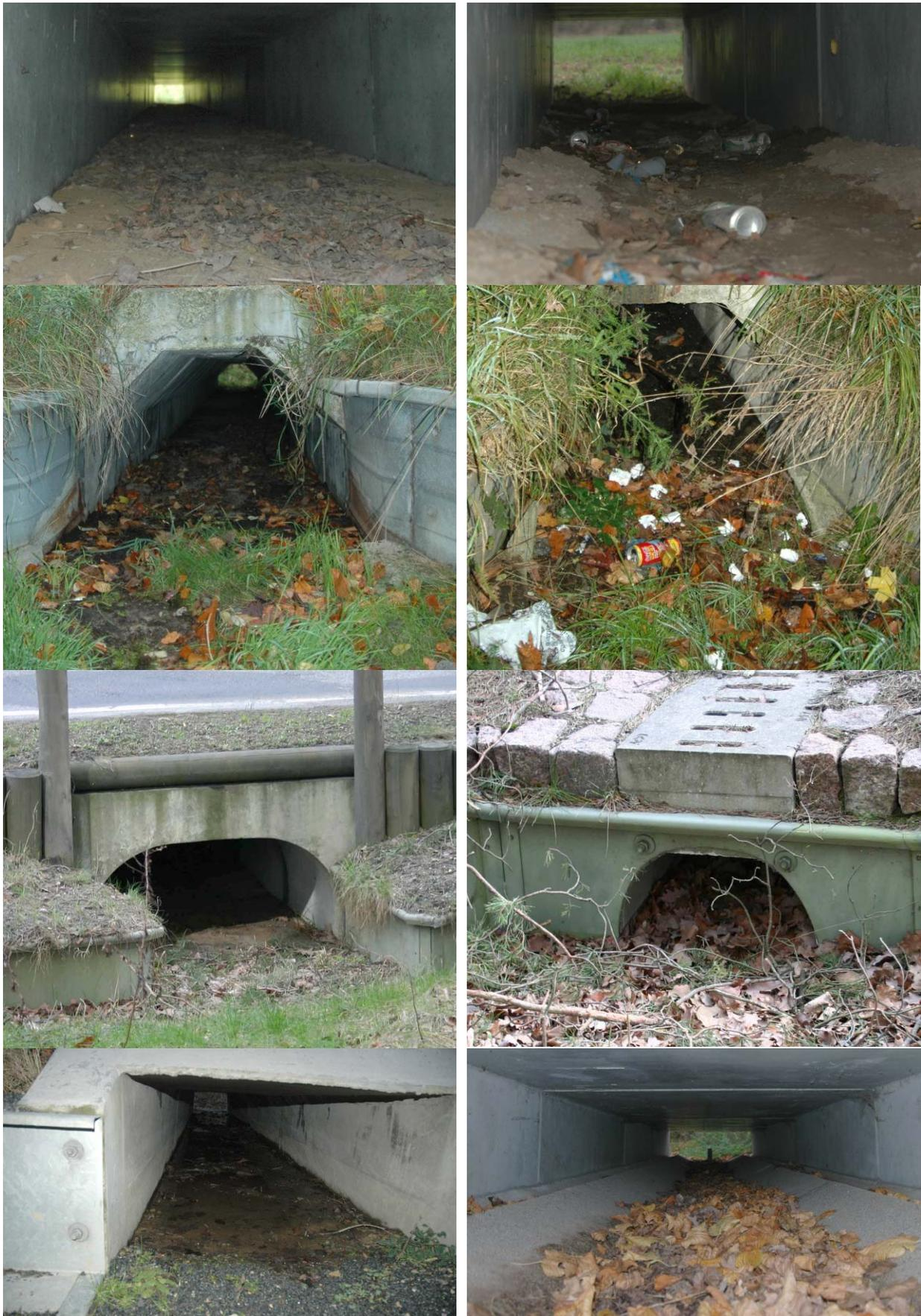
**Abbildung 43: Beispiele zur Untersgrundsituation vor und in verschiedenen Durchlässen**
