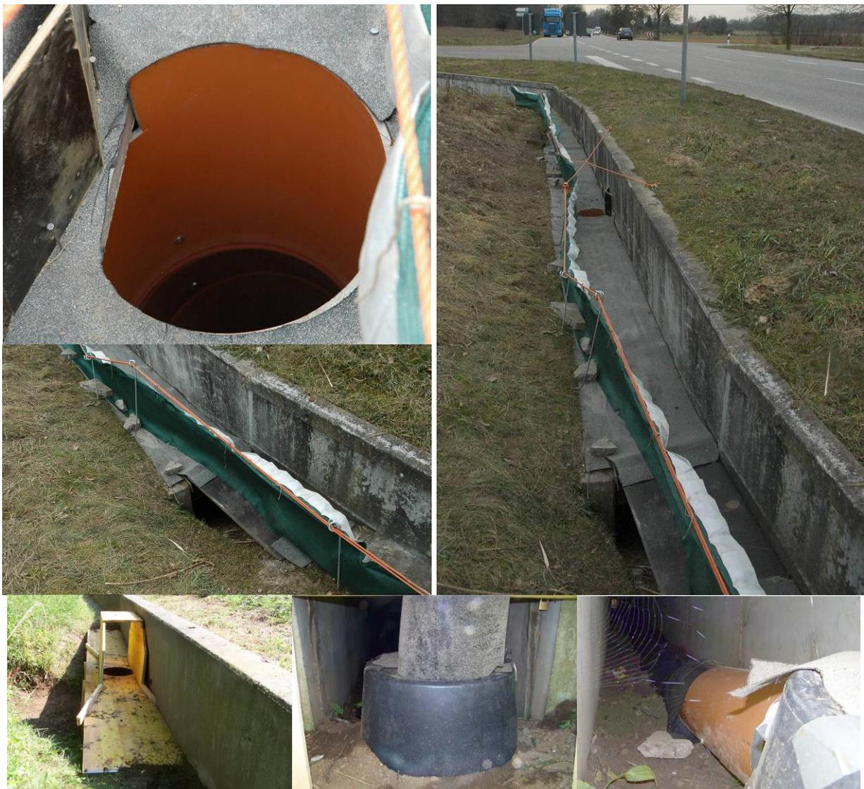
**Abbildung 22: Montage eines Fallrohrs an je einem Tunneleingang eines Stelztunnels an der B 3 bei Karlsruhe im Frühjahr (oben) sowie im Sommer (unten) 2009**
