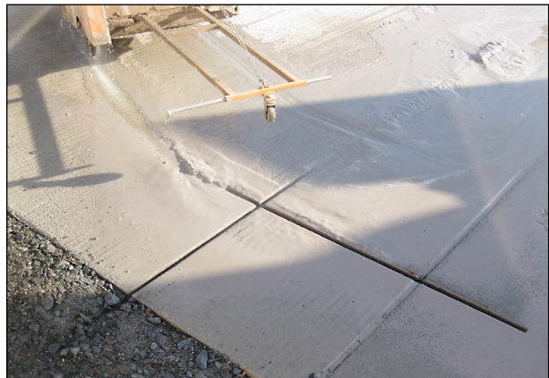
Bild 90: Fertige Schlitzarbeiten für Sensorsystem 2R an der Fuge zwischen Betonfahrbahnplatte neun und zehn
