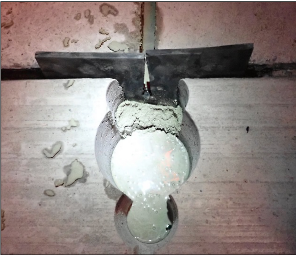
Bild 105: Fertig vorbereitetes Bohrbild mit Vergusschablone, Vergussmörtel und Abdichtungsmörtel
