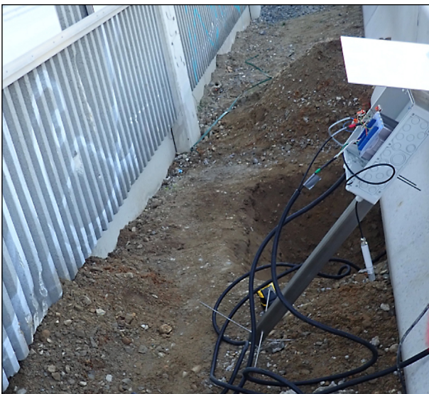
Bild 84: Ausgehobene Grube hinter der Leitplanke zur Durchführung der Messkabel
