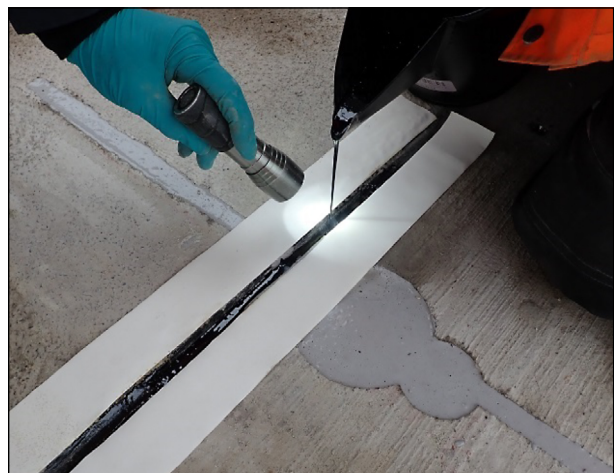
Bild 119: Heiß-Verguss der Fuge
