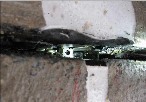
Bild 115: Vorbereitete Fuge ohne Unterfüllschnur
