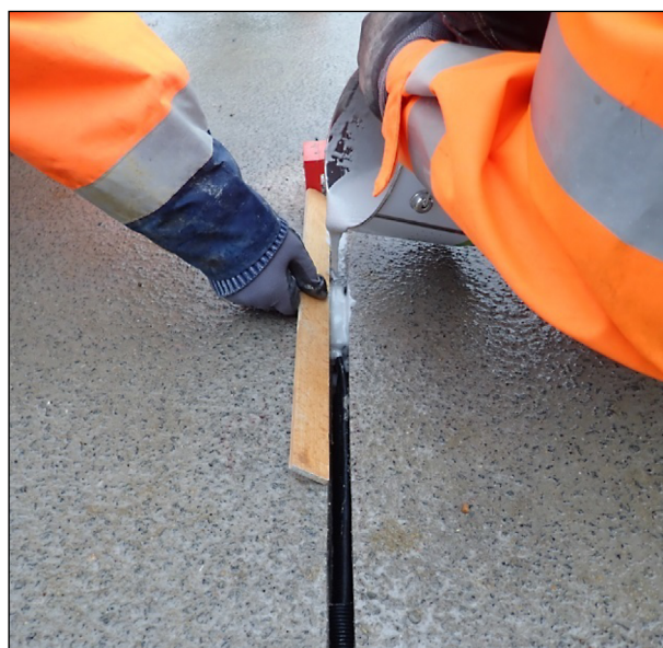
Bild 122: Verschluss des Leitungsschlitzes für die Temperatursensoren
