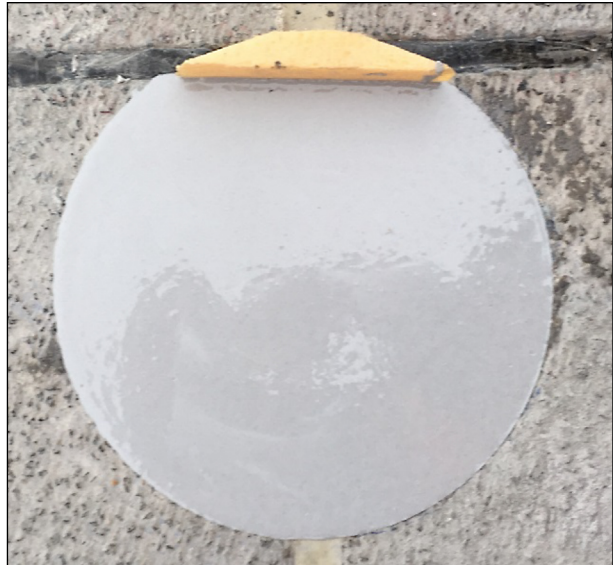
Bild 136: Bohrloch unmittelbar nach Verfüllung
