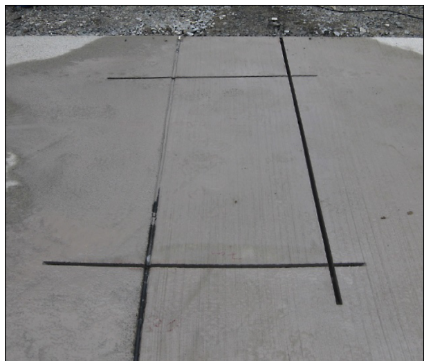
Bild 91: Fertiges Schlitzbild an der Fuge zwischen Betonfahrbahnplatte neun und zehn
