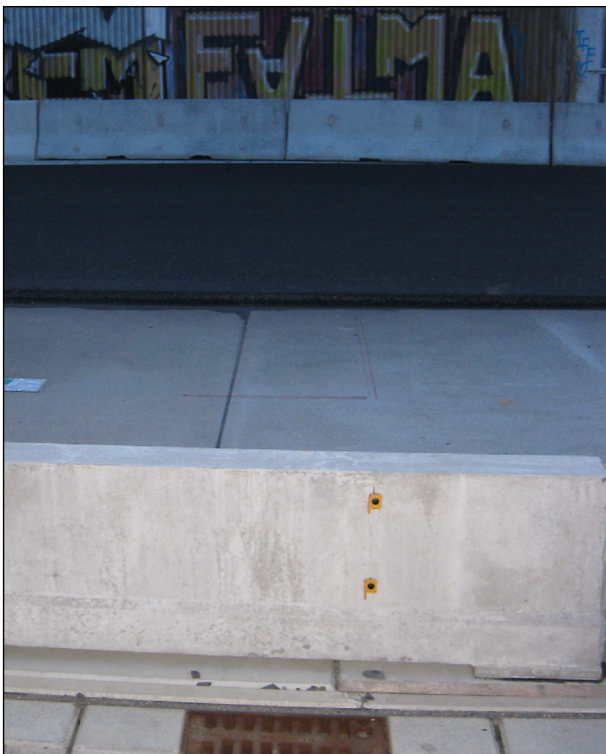
Bild 88: Anzeichnen der Schlitzmaße auf der Fertigteilbetonstrecke
