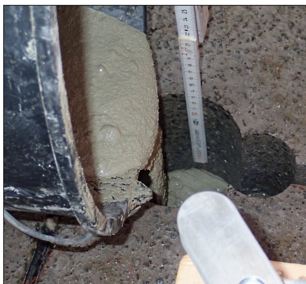
Bild 104: Einfüllen des Vergussmörtel bis 13 cm unter Oberkante
