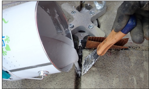
Bild 107: Verschluss des Anschlussgalgens
