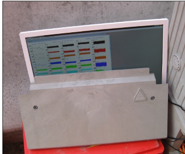
Bild 98: Prüfung der Sensoranzeigen der Sensorsysteme
