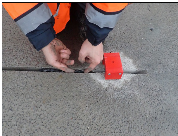
Bild 121: Verlegung der Anschlusskabel für die Temperatursensoren; Fixierung in rot
