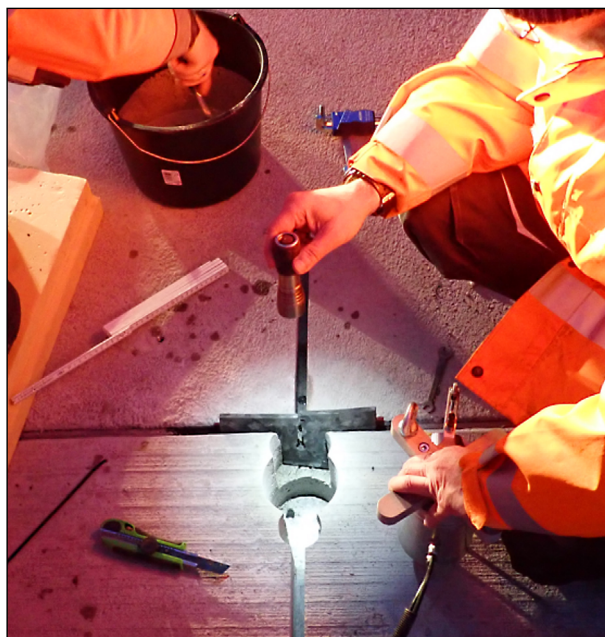
Bild 103: Eingebraachte Vergusschablone in der Fugenkammer mit Sensorsystem kurz vor der Installation
