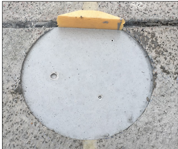
Bild 137: Verfülltes Bohrloch (Gießbeton ausreagiert)
