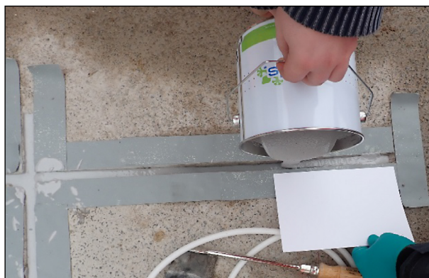
Bild 113: Verguss der Leitungsschlitzte
