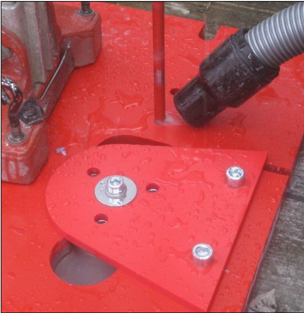
Bild 96: Bohrarbeiten der zwei 12 mm Bohrungen für die Fixierung des Anschlussgalgens; vorne ist bereits die zweite Bohrschablone in das große Bohrloch eingebracht und auf der unteren Bohrschablone fixiert
