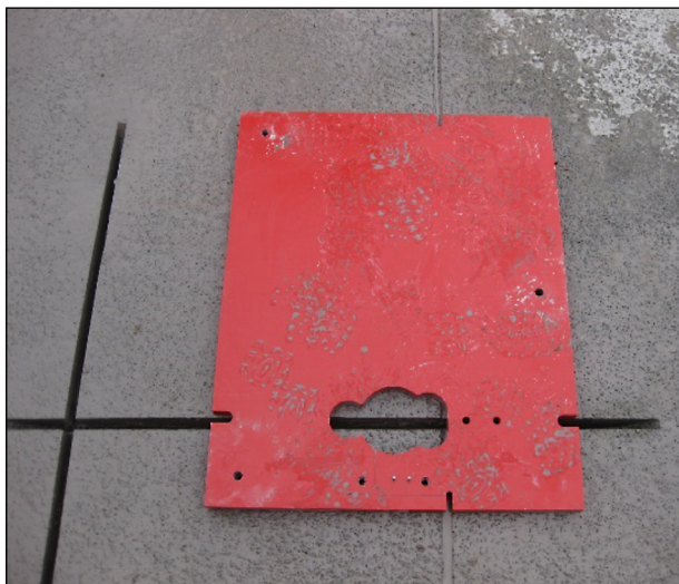
Bild 93: Positionierte Bohrschablone
