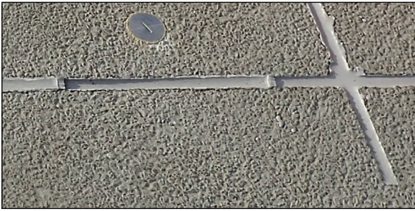
Bild 79: in die Leitungsschlitzte eingebrachte Wehre aus Schaumstoff, um einen zur Plattenoberkante ebenen Abschluss zu erzeugen
