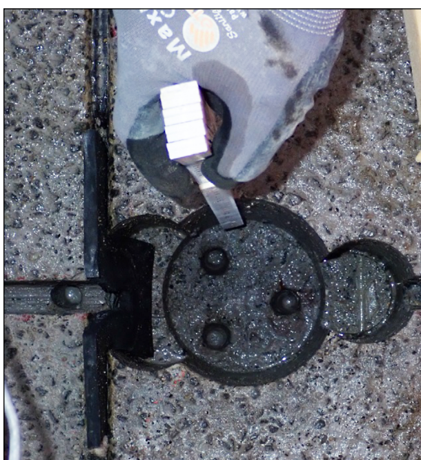
Bild 101: Prüfen aller Bohrtiefen mit Zollstock
