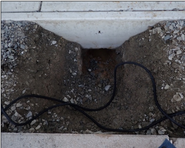
Bild 82: Ausgehobene Grube vor dem Kabelkanal und vor der Leitplanke zur Durchführung der Messkabel
