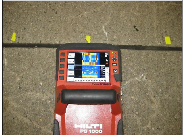
Bild 86: Auffinden der Dübel mithilfe eines Radargeräts
