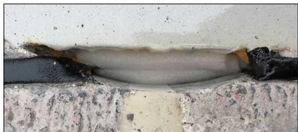
Bild 138: Fuge mit eingebrachter Unterfüllschnur
