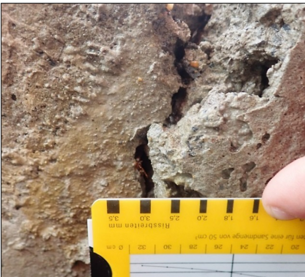
Bild 237: Fuge zwischen Platte 9 und 10 im März 2018; mit 3,0 mm Ausbildung des Kerbrisses
