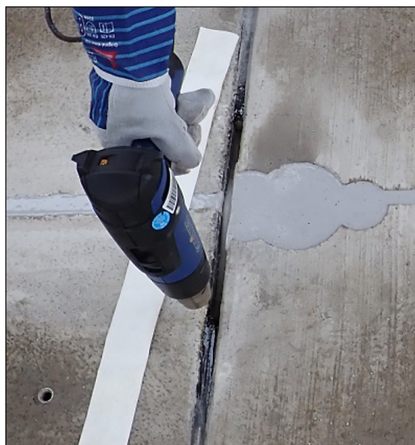
Bild 114: Trocknung der Fugenkammer
