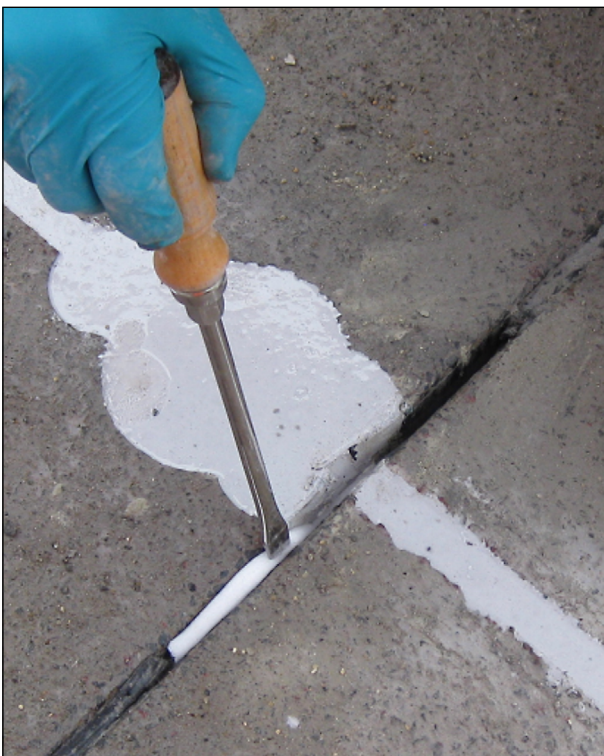
Bild 117: Einbringen der Unterfüllschnur in die Fugenkammer
