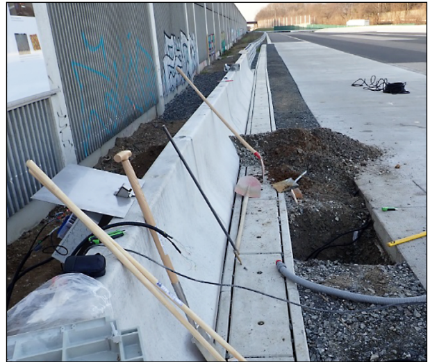
Bild 85: Grube vor der Leitplanke zur Durchführung der Messkabel
