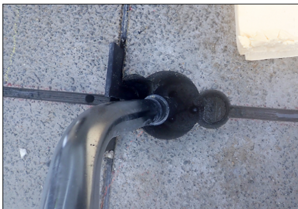
Bild 100: Reinigung des fertigen Bohr- und Schlitzbildes
