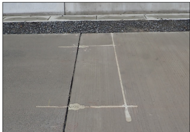
Bild 120: Verschlussene Sensorsysteme 2R und 2M an der Fuge zwischen Betonfahrbahnplatte neun und zehn
