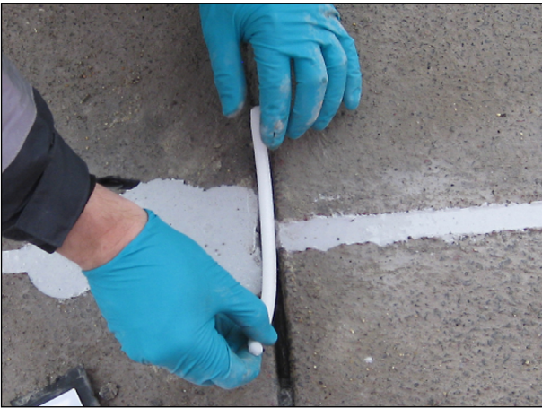
Bild 116: Unterfüllschnur für Heiß-Verguss
