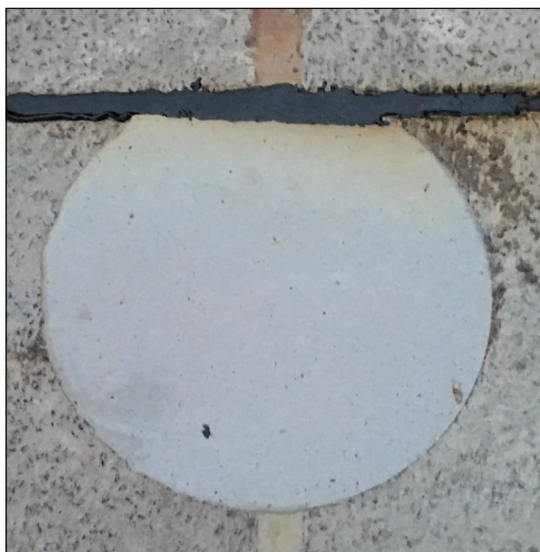
Bild 139: Vergossene Fuge
