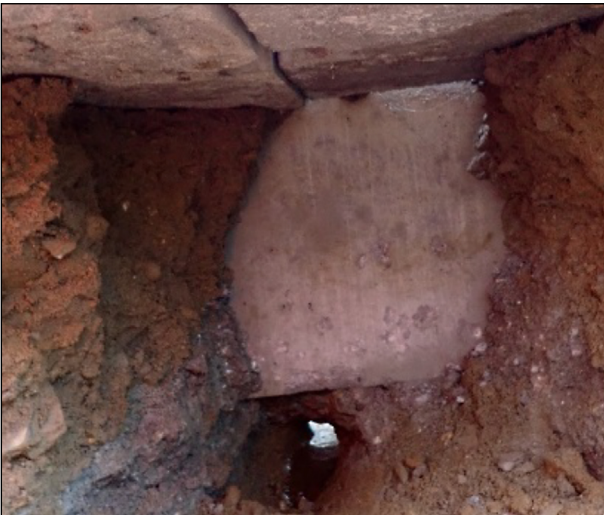
Bild 83: Durchbruch unter dem Kabelkanal zur Durchführung der Messkabel
