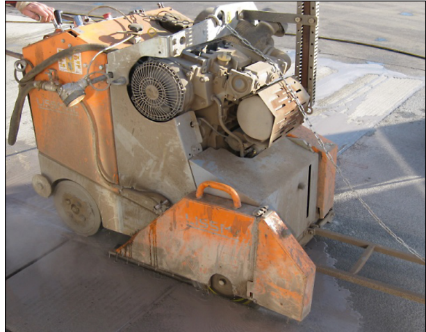
Bild 89: Schlitzarbeiten an der Fuge zwischen Betonfahrbahnplatte neun und zehn
