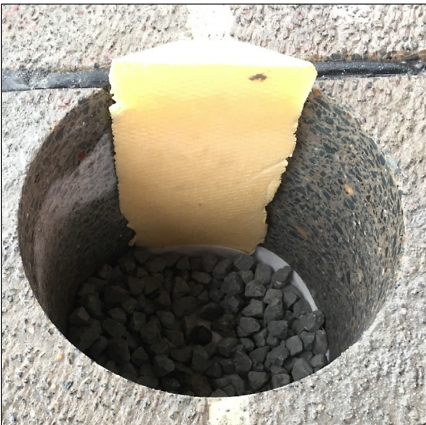
Bild 135: Ausbau-Bohrloch vor Verschluss
