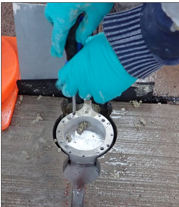
Bild 109: Abnahme der Einbaulehre
