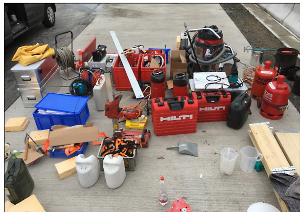
Bild 81: Baustelleneinrichtung, Bohr-Schablonen, Werkzeug, Einbau- und Verschlussmaterialien auf dem dura-BAST
