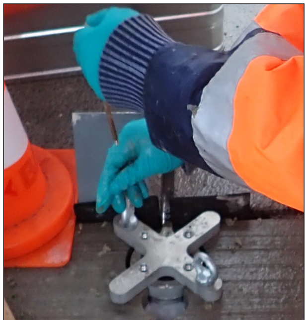
Bild 108: Entfernung des Einbaukreuzes
