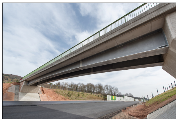
Bild 45: Gesamtansicht der fertiggestellten Brücke (DEGES/ Frank Zerbst)
