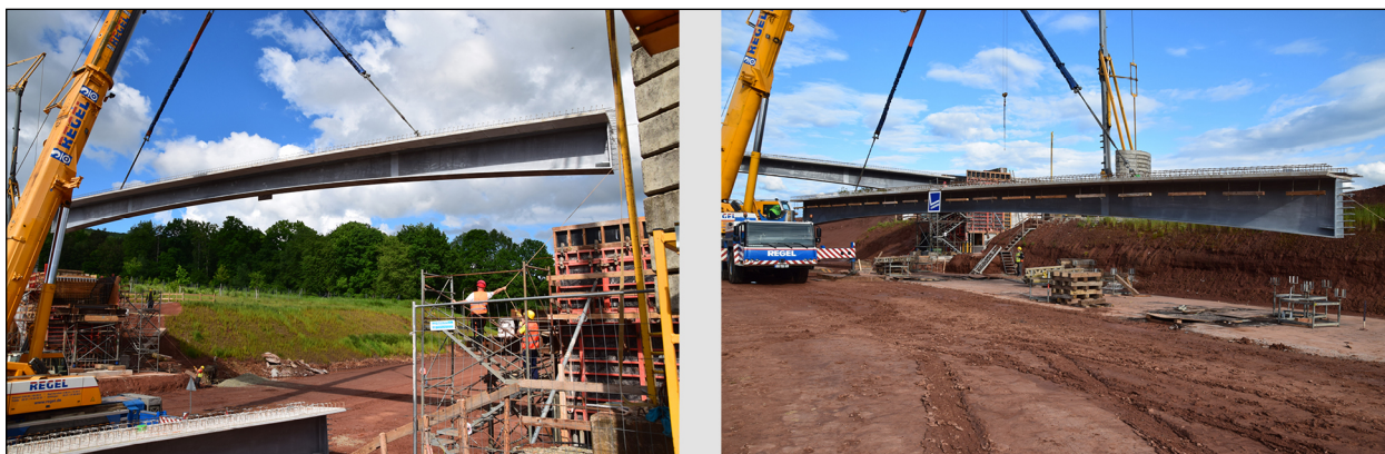
Bilder 15.1 und 15.2: Einheben der Brücke (DEGES)
