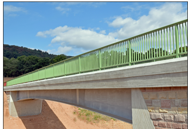
Bild 2: Feuerverzinkte Stahlverbundbrücke über die A 44 bei Bischhausen (IFG)
