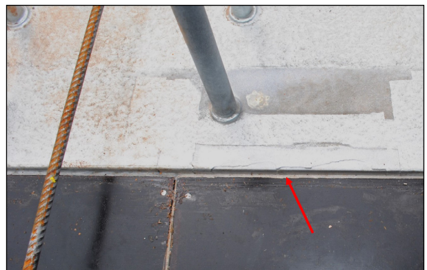
Bild 30: Abdichtung der Fuge zwischen Betonschalung und Stahlträger mit einem für Zinküberzüge geeigneten Silikon (IFG)
