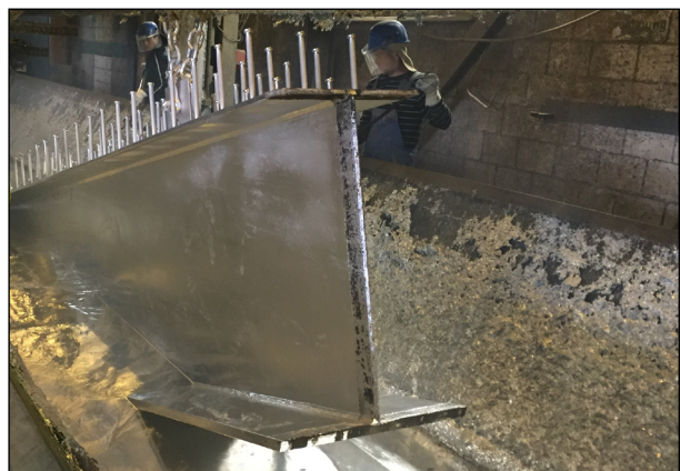
Bild 32: Äußeres Brückensegment während des Feuerverzinkungsprozesses (IFG)
