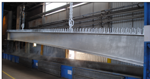
Bild 34: Mittleres Brückensegment nach dem Feuerverzinkungsprozess (IFG)
