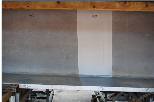
Bild 13: Thermisch gespritzter Baustellenschweißstoß mit Markierungspunkten für die Langzeitmessung (IFG)
