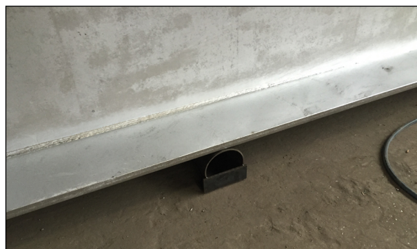
Bild 37: Auf den mittig positionierten Absetzböcken abgelegtes Bauteil (IFG)
