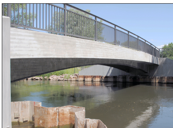
Bild 16: Elster-Brücke in Halle - Deutschlands erste feuerverzinkte Stahlverbundbrücke in Verbunddübel-Bauweise (IFG)
