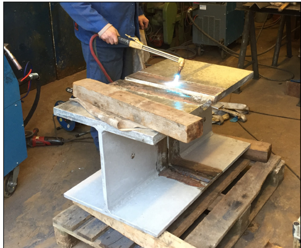
Bild 24: Arbeitsproben - Herstellung des Montageschweißstoßes (IFG)
