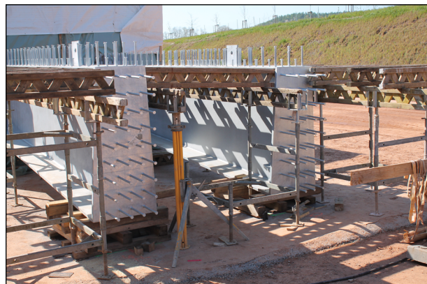
Bild 12: Einrichtung der Feldfabrik (IFG)
