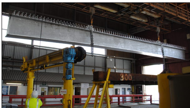
Bild 35: Krantransport des mittleren Brückensegmentes nach dem Feuerverzinkungsprozess (IFG)
