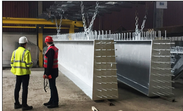
Bild 31: Qualitätskontrolle der fertigen feuerverzinkten Brückensegmente (IFG)
