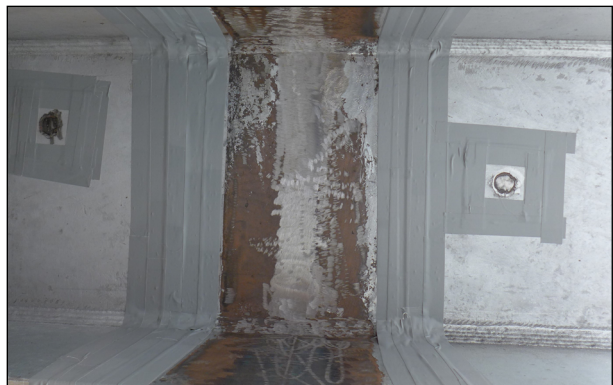
Bild 25: Maskierte (abgeklebte) Arbeitsproben im Bereich des Montageschweißstoßes (IKS)
