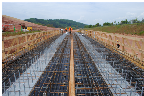
Bild 14: Vorbereitung der Schalung für das Halbfertigteil (IFG)
