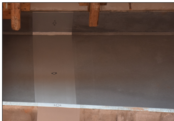
Bild 42: Thermisch gespritzter Baustellen-Schweißstoß (Achse A) mit markierten Punkten für die Langzeitmessung (IFG)
