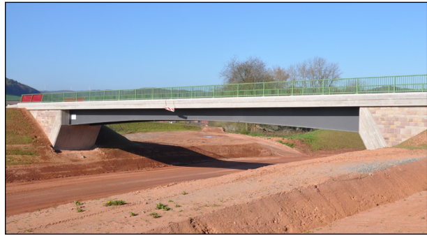
Bild 5: Vergleichsbauwerk BW 08, konventionell organisch beschichtet (DEGES)
