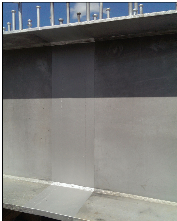
Bild 39: Thermisch gespritzter Baustellenschweißstoß mit Versiegelung in RAL 9006 (IKS)
