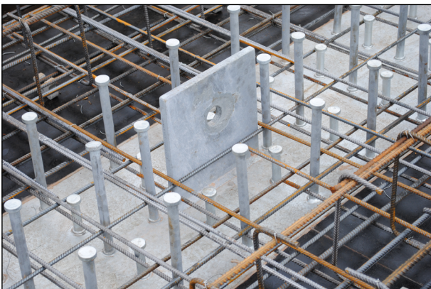
Bild 43: Zu klein dimensionierte Öffnung in der aufgeschweißten Lasche (IFG)
