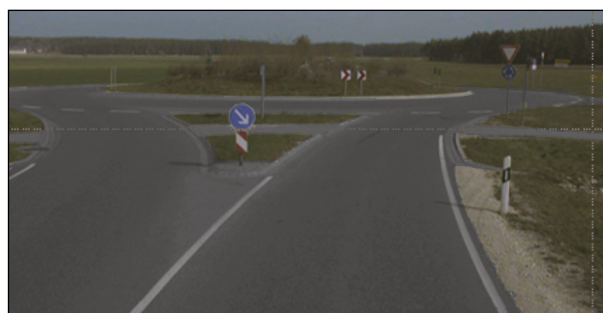
Bild 170: Fahrbahnteiler mit dem Fahrbahnverlauf angepassten Rändern und Querungsstelle in Dreiecksform (Bildquelle: ZEB, 2018)
