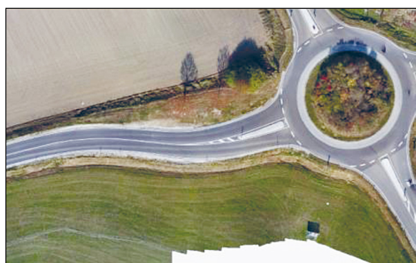
Bild 136: Orthofoto einer Zufahrt mit Verschwenkung
