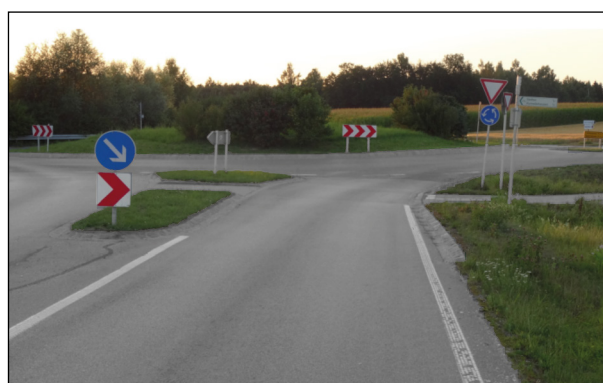
Bild 171: Fahrbahnteiler mit dem Fahrbahnverlauf angepasster Bordführung (Bildquelle: eigene Aufnahme)
