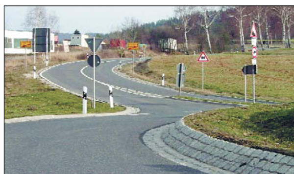
Bild 39: Beispiel für einen Kreisverkehr mit Aufkantung zur Mittelinsel | Deutschland (SPAHN & BÄUMLER, 2007)
