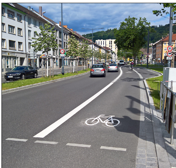
Bild 7: Überbreite Richtungsfahrbahn mit angrenzendem Radfahrstreifen (Bildquelle: Stadt Freiburg)
