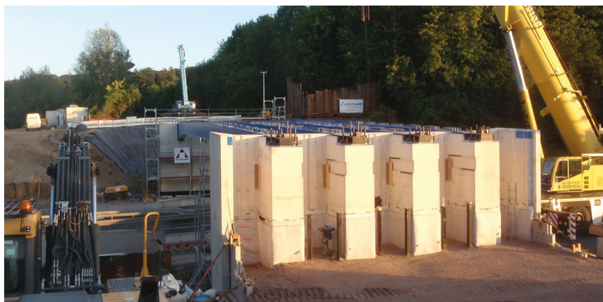
Überführungsbauwerk in Modulbauweise
