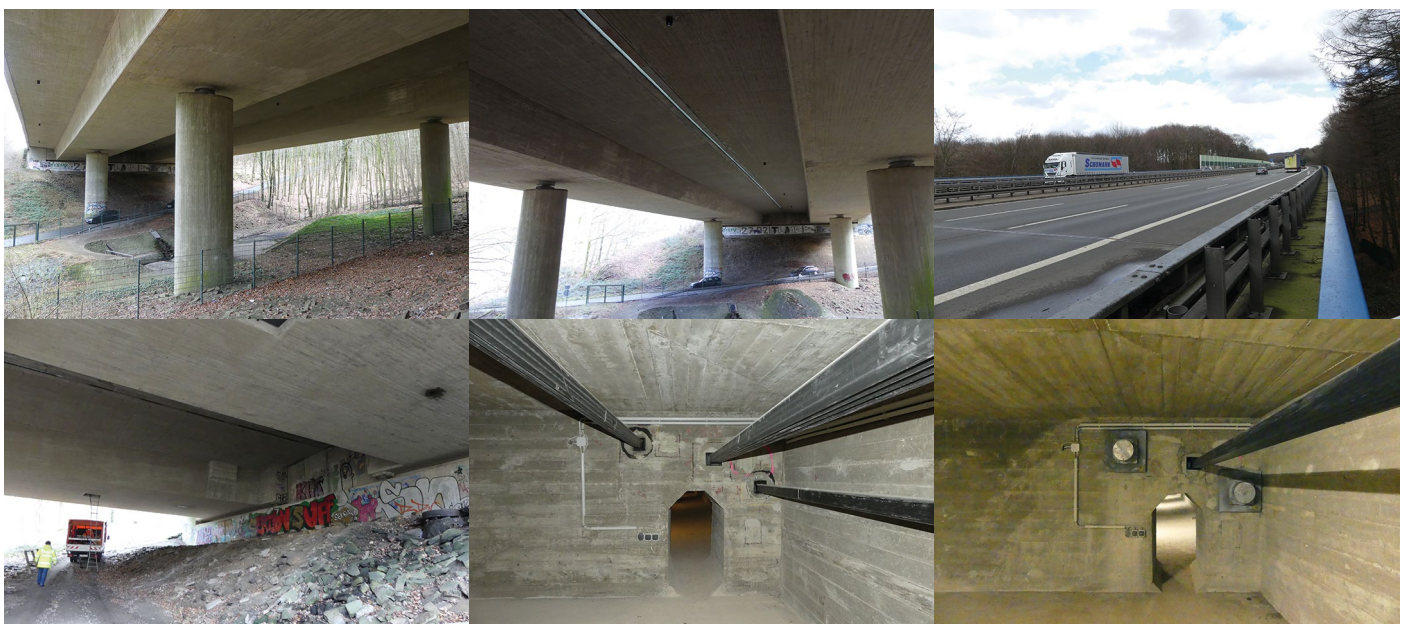
Talbrücke Sachsengraben A45
