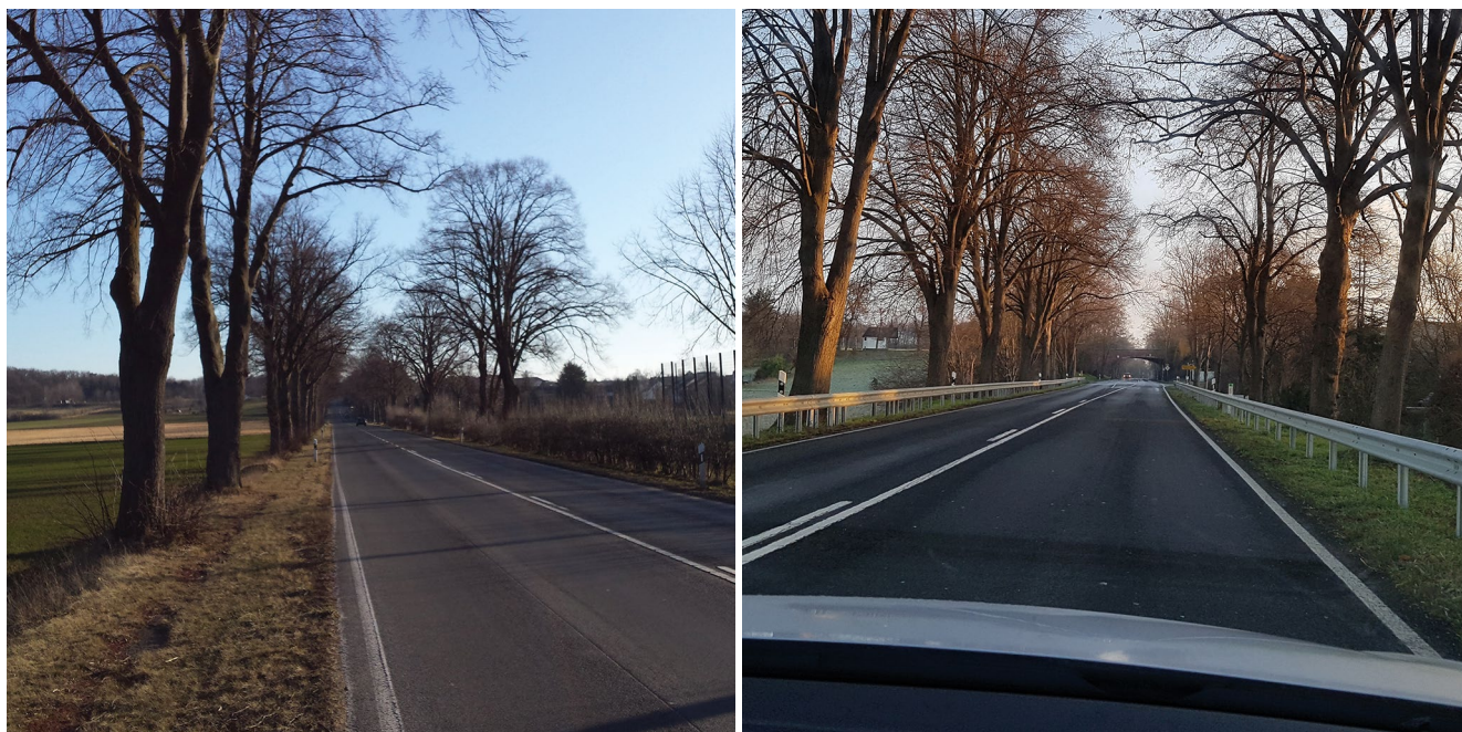
Landstraße vor (links) und nach (rechts) der Absicherung mit Schutzeinrichtungen
