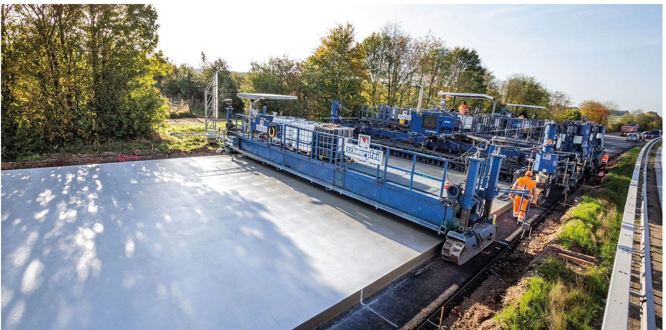
Betondeckeneinbau (Bild: Fa. Schnorpfeil)
