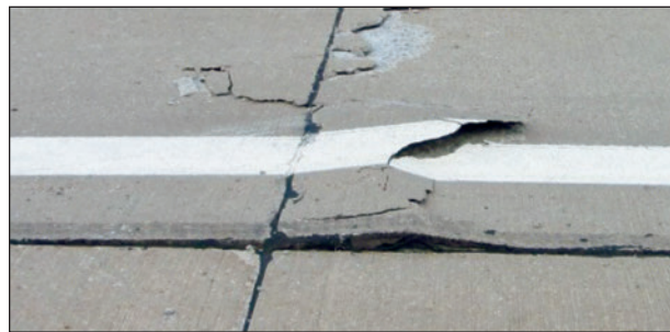
Bild 20: Typischer Hitzeschaden
