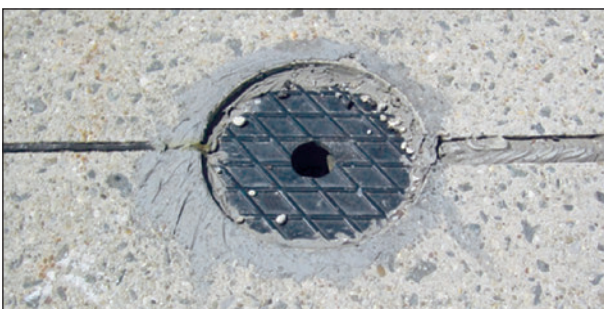
Bild 77: Demontierbarer und befahrbarer Bohrlochverschluss
