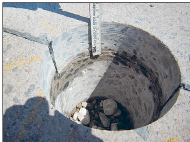
Bild 73: Horizontalschnitt im Bereich der Querscheinfuge
