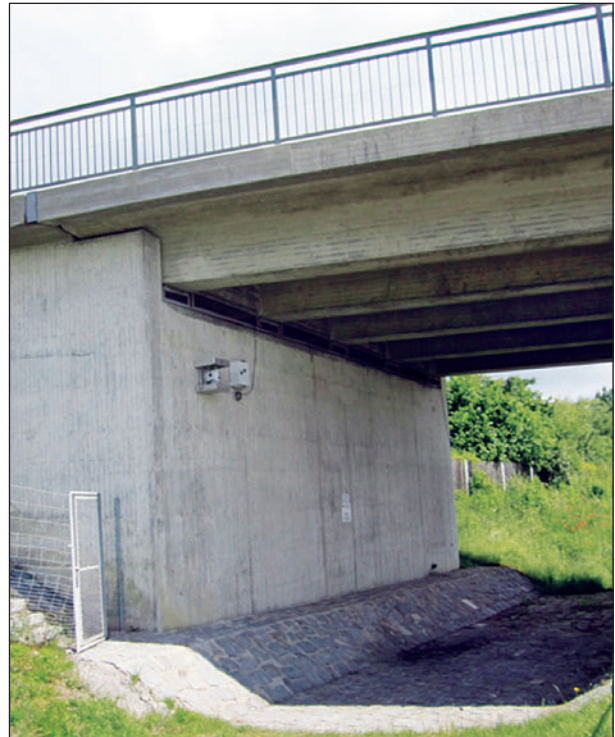
Bild 47: Am Widerlager montierte Multistation
