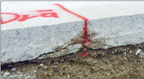
Bild 23: Geschädigter Fugenbereich
