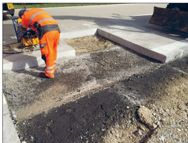
Bild 81: Entnahme der Plattensegmente für die Kalibrierungsversuche
