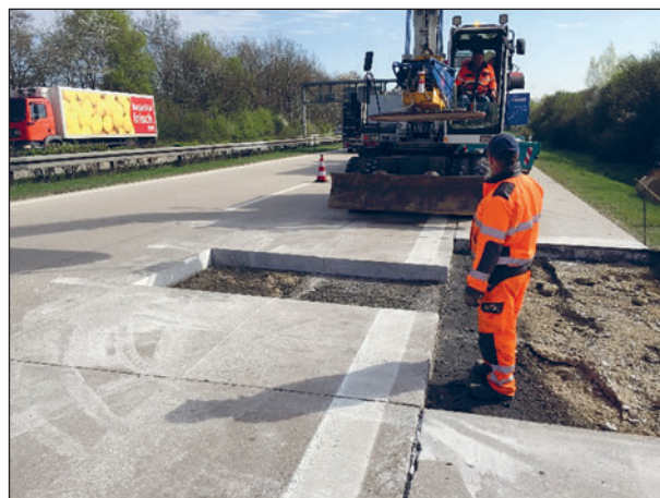
Bild 80: Entnahme der Plattensegmente für die Kalibrierungsversuche
