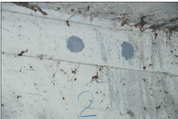
Bild 45: Zustand des Bauwerks nach dem Füllen mit Injektionsmörtel
