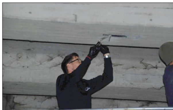
Bild 49: Entfernen der Silberfolie mit einem Spachtel
