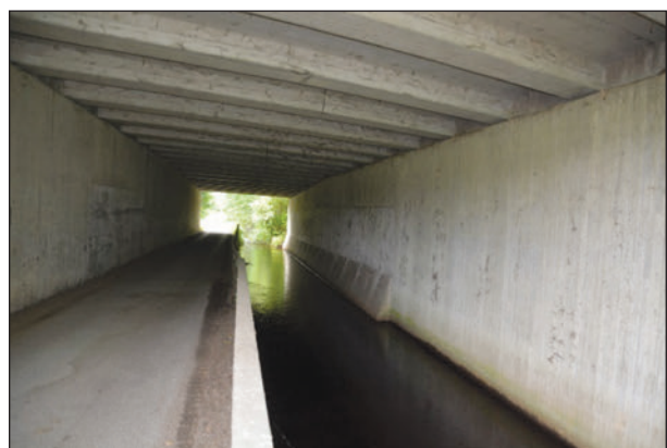
Bild 27: Arbeitsbereich unterhalb der Brücke
