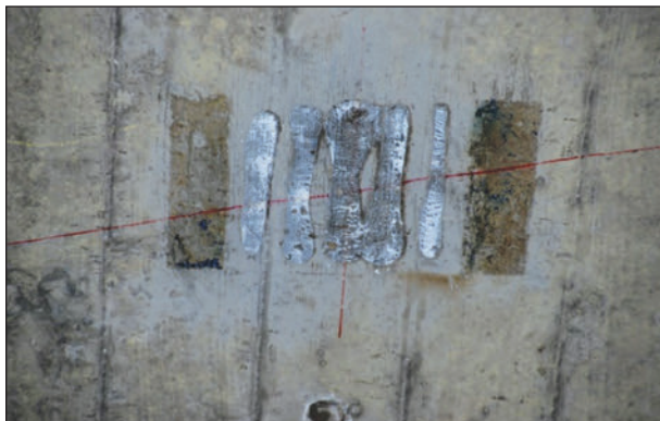
Bild 55: Zustand der Brücke nach der Demontage der Träger
