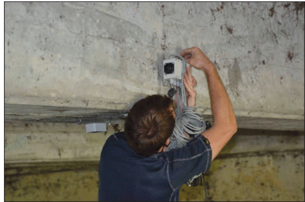
Bild 13: Stufe 3: Befestigung der Sensoren
