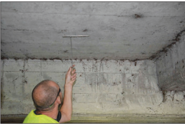
Bild 12: Stufe 2: Herstellung der Bohrlöcher
