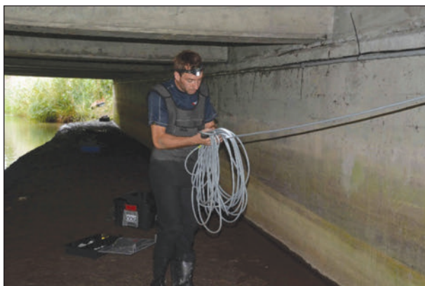
Bild 16: Stufe 6: Herstellung der Verbindung Sensoren – Signalverteiler – Auswerteeinheit
