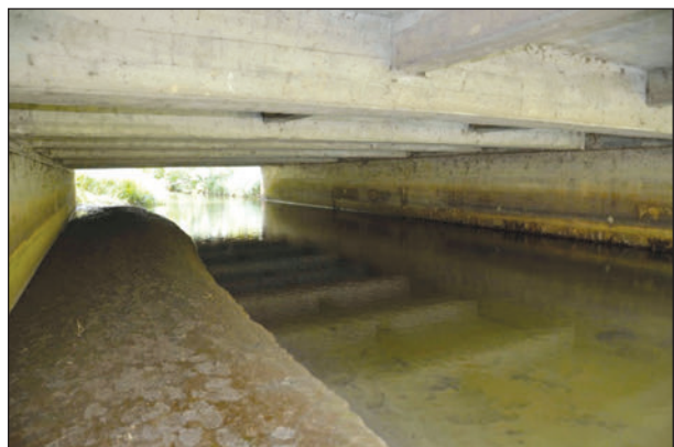
Bild 8: Arbeitsbereich unterhalb der Brücke
