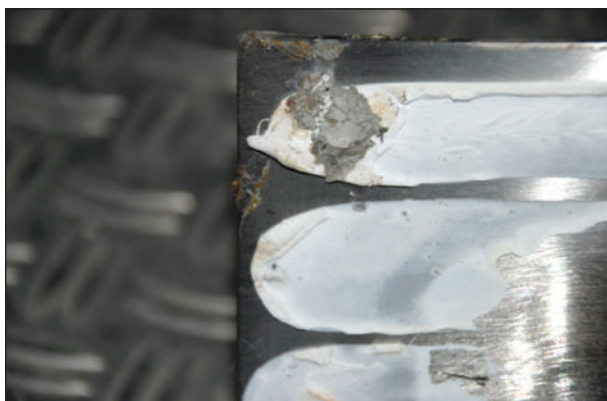
Bild 56: Minimale Betonrückstände am demontierten Träger
