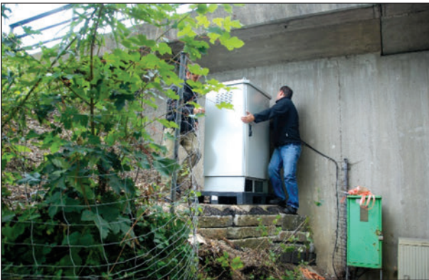
Bild 32: Stufe 4 – Aufstellen Schaltschrank
