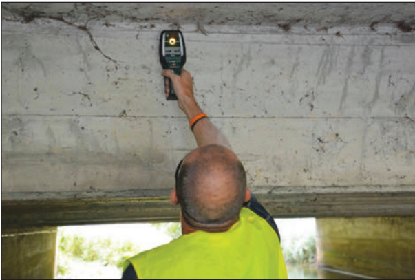
Bild 11: Stufe 1: Prüfung auf Bewehrung
