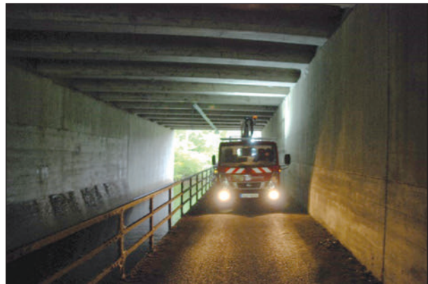
Bild 26: Hubsteiger unter der Brücke
