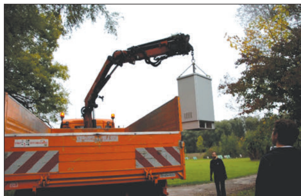
Bild 58: Abtransport des Schaltschranks
