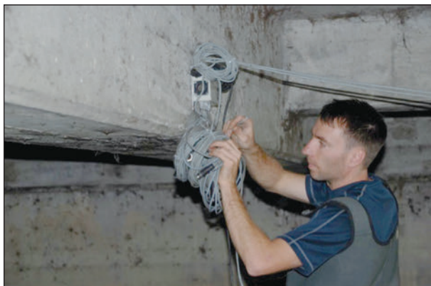
Bild 39: Aufwickeln und Fixieren der Kabel am Signalverteiler
