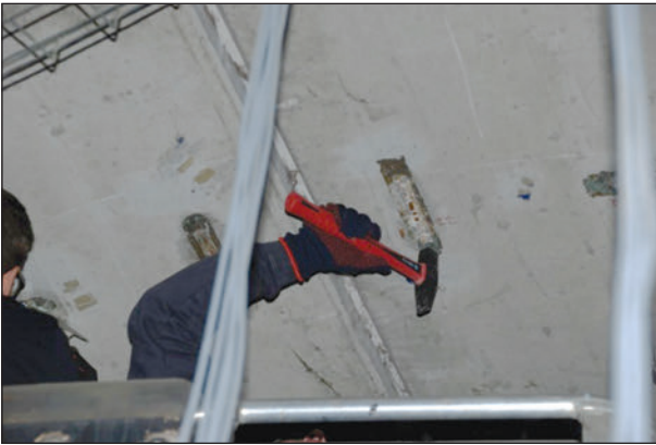
Bild 50: Abschlagen des Sensors mit einem Hammer
