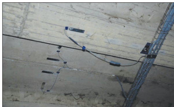
Bild 48: Durchhängendes Kabel
