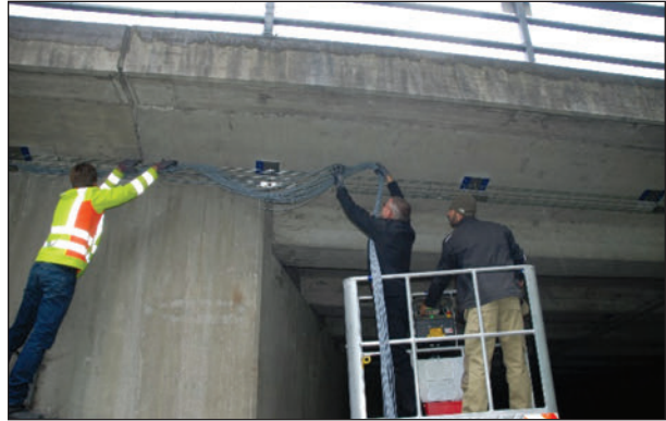
Bild 33: Stufe 5 – Verlegung Kabel in Traverse
