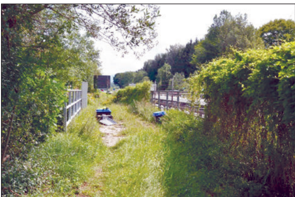
Bild 6: Bereich oberhalb des Brückenbauwerks
