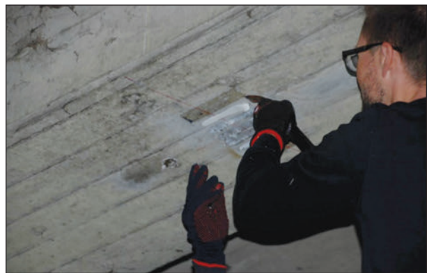
Bild 53: Entfernen der Klebereste
