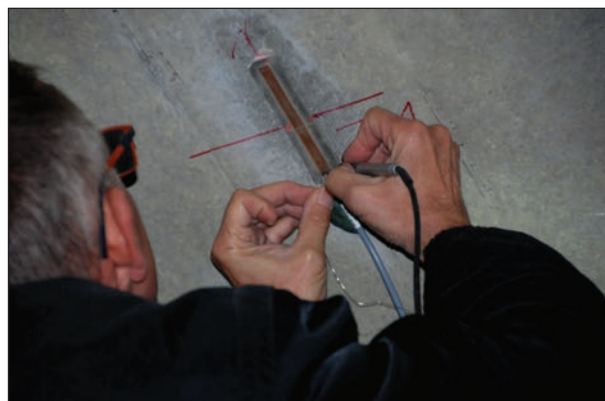
Bild 35: Stufe 7 – Verkabeln der Sensoren
