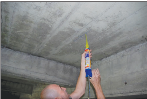
Bild 44: Füllen der Löcher mit Injektionsmörtel
