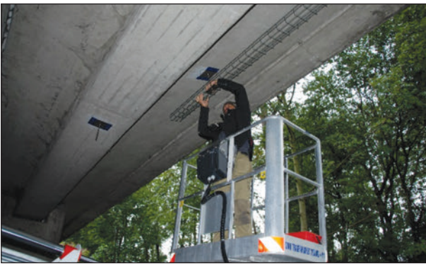
Bild 31: Stufe 3 – Anbringen Traverse
