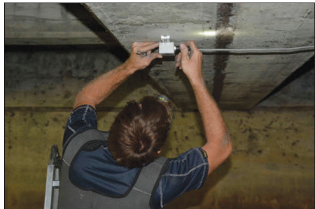
Bild 14: Stufe 4: Verbindung der Sensoren
