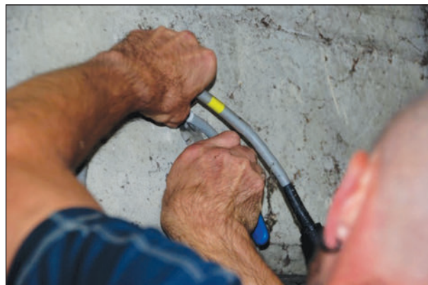
Bild 41: Trennen der Befestigung eines Kabel
