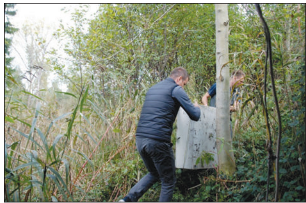
Bild 47: Transport des Schaltschrank die Böschung hoch
