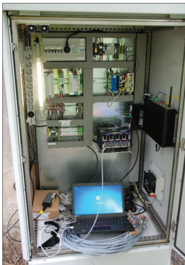
Bild 36: Stufe 8 – Anschluss und Einrichten Schaltschrank
