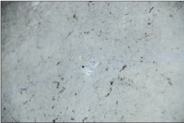
Bild 43: Plastikreste der Kabelhalterung nach der Demontage
