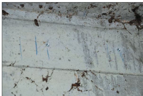
Bild 42: Bohrlöcher (inklusive Dübel) nach der Demontage
