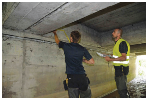
Bild 10: Stufe 1: Ausmessen der Brücke und Festlegung der Positionen
