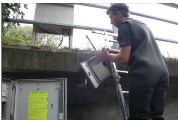
Bild 17: Stufe 7: Montage der Datenübertragungseinheit
