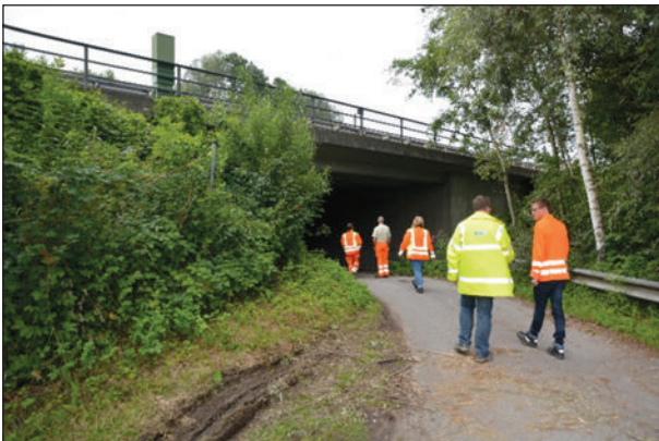
Bild 24: Zuweg zum Brückenbauwerk im untergeordneten Netz
