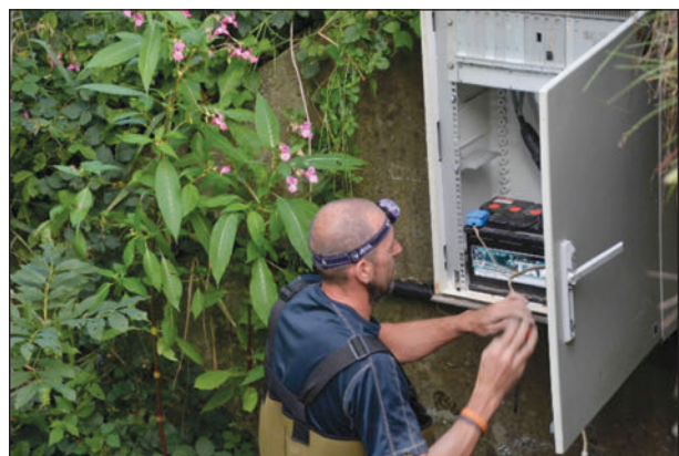
Bild 15: Stufe 5: Montage des Schaltschranks
