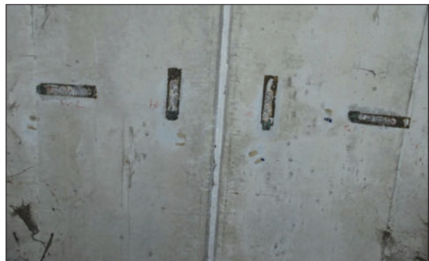
Bild 54: Zustand der Brücke nach der Demontage der Sensoren
