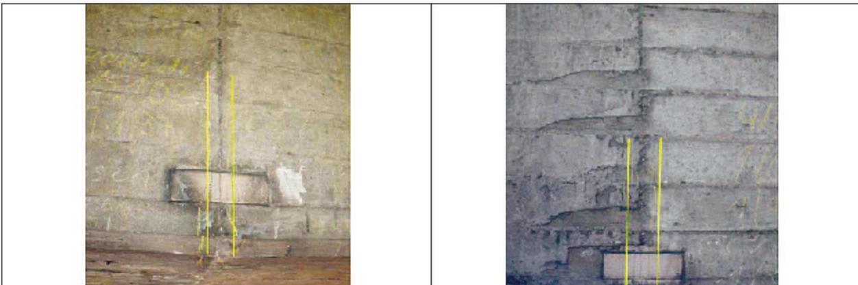
Bild 88: Gerissene Koppelfugen: Querrisse, Breite 0,1 mm, Länge: 40,0 cm an zwei Koppelfugen [200]
