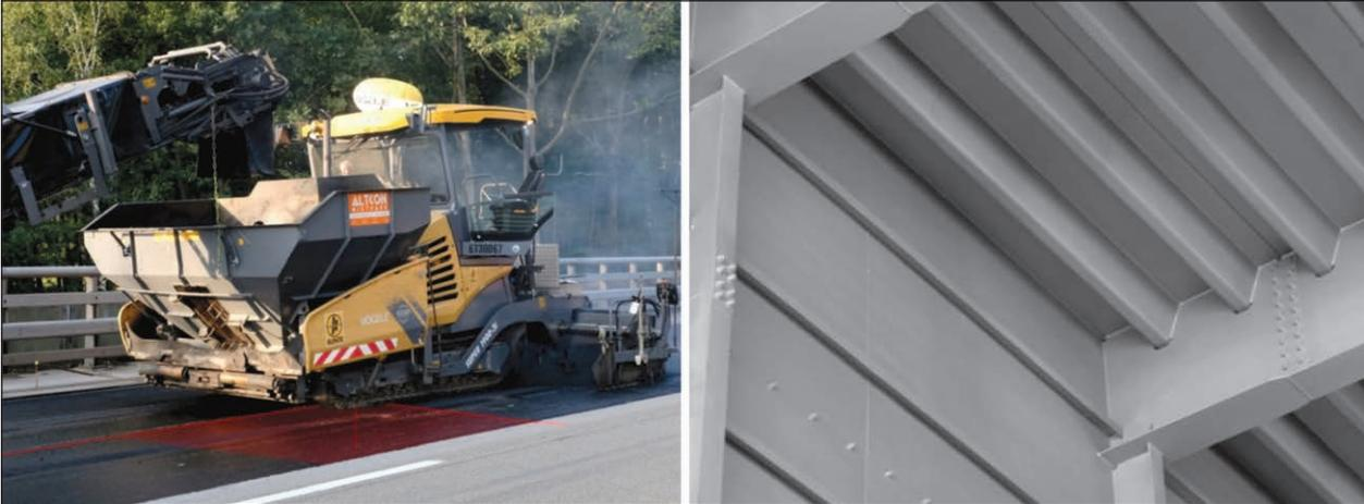
Bild 14: Einbau der Deckschicht 20:15 Uhr: Fertiger vor dem Messfeld (links); Messfeld von unten bei QT Nr. 172 (rechts)
