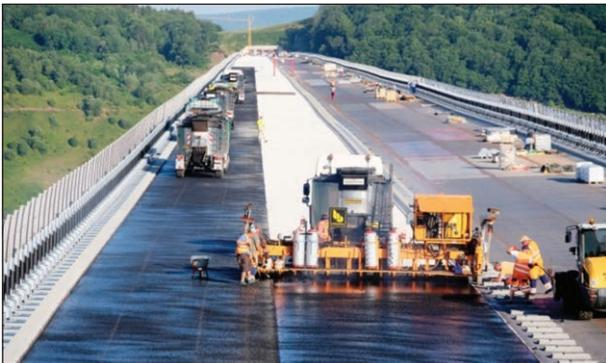
Bild 36: Einbau Gussasphalt-Schutzschicht am 28.06.2019
