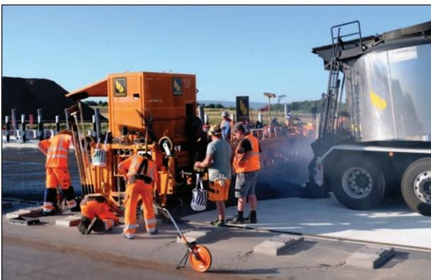
Bild 37: Einbau Gussasphalt-Schutzschicht am 28.06.2019
