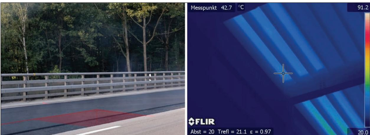
Bild 16: Einbau der Deckschicht 20:30 Uhr: Der Fertiger hat das Messfeld verlassen (links); IR-Aufnahme von unten (rechts)
