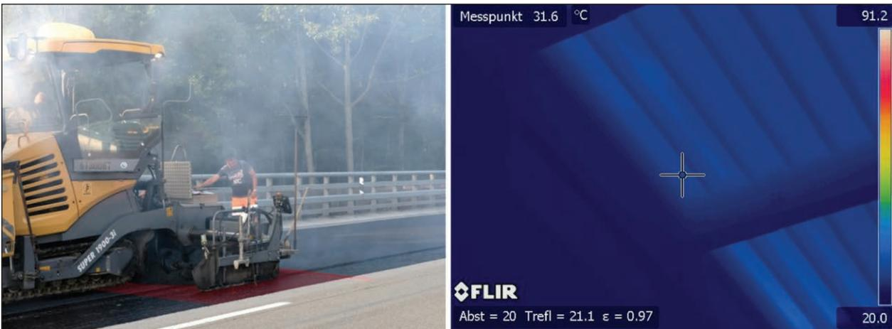
Bild 15: Einbau der Deckschicht 20:18 Uhr: Der Fertiger befindet sich auf dem Messfeld (links); IR-Aufnahme von unten (rechts)
