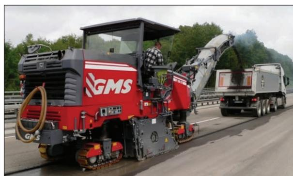
Bild 13: Fräsarbeiten
