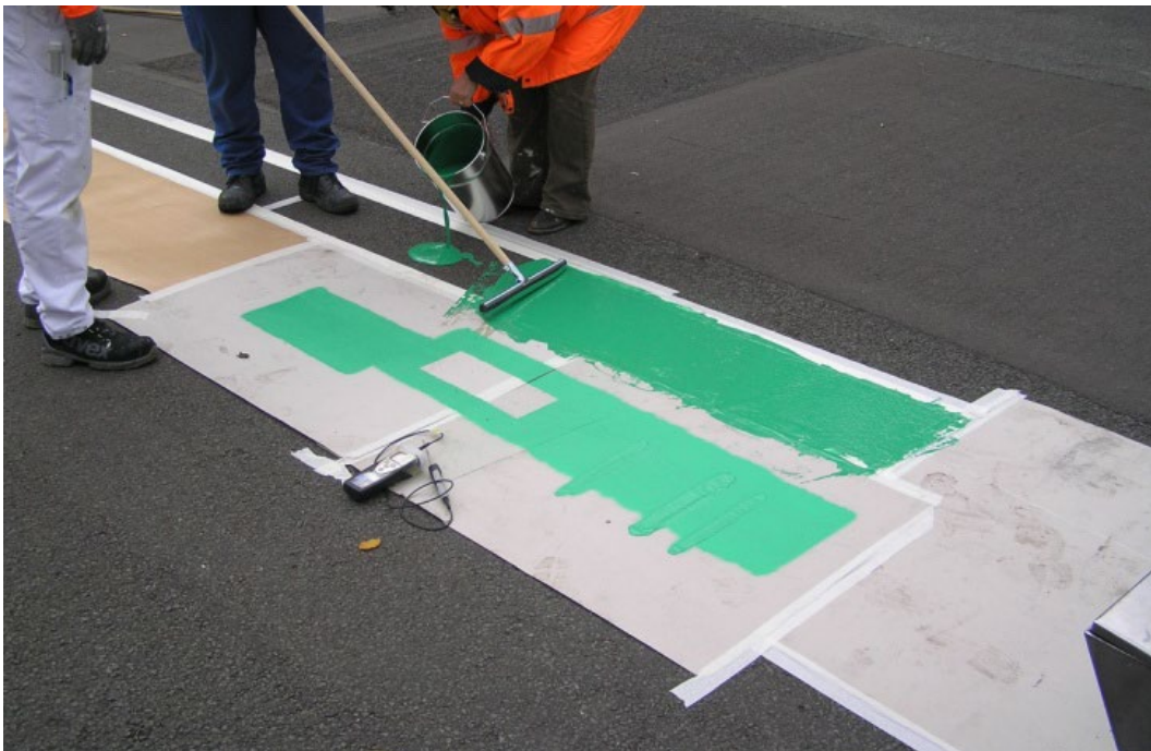
Abbildung A- 4: Manuelle Applikation der Kaltplastik
