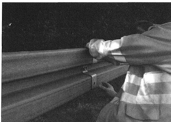
Bild 2: Markieren der Messpunkte mittels Schablone
